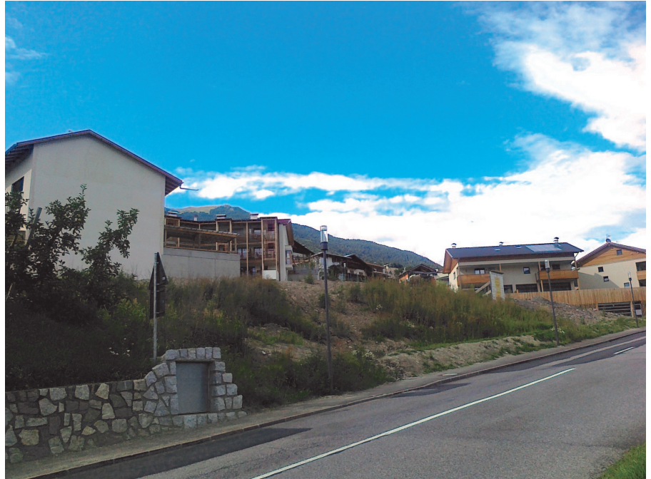
Blick auf die Wohnbauzone Mooswiese mit dem Baugrundstück des Wohnbauinstitutes im Vordergrund.
