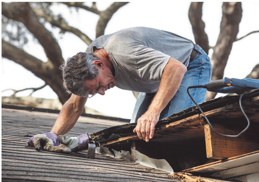
An die 9000 Instandhaltungseingriffe werden jedes Jahr durchgeführt.
