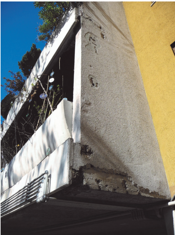
21 Mio. Euro werden für die außerordentliche Instandhaltung ausgegeben.
