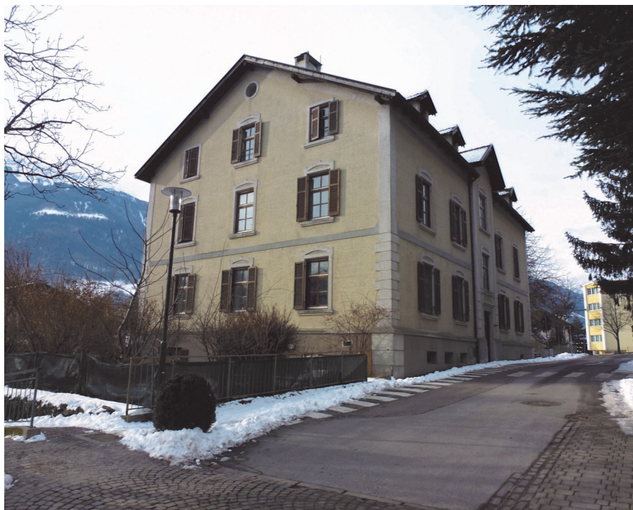
Das Gebäude des ehemaligen Altersheimes, wie es sich vor dem Umbau präsentiert.
