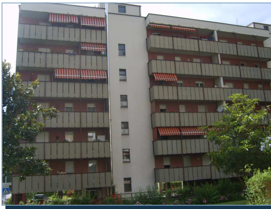
Das Gebäude in Leifers, Weinbergweg 21-23 vor der Sanierung ...
