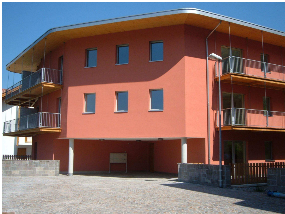
Das erste, als Pilotprojekt errichtete, Passivhaus des Wohnbauinstitutes in Branzoll mit 8 Wohnungen, 2006, geplant von Arch. Michael Tribus.
