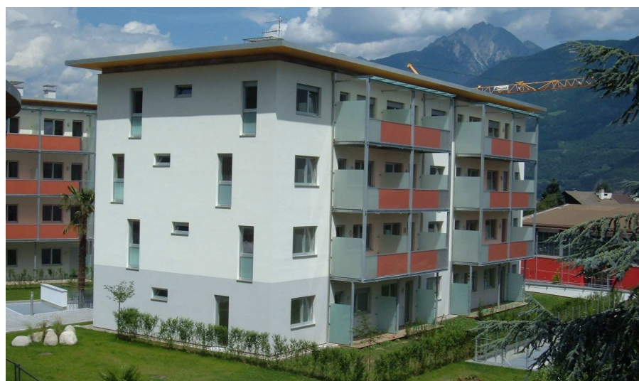
Lana, „Hofmann Anger“ Höflerstraße 3-5, 20 Wohnungen, 2008, geplant von Arch. Sabina und Arch. Klaus Valtingoier.
