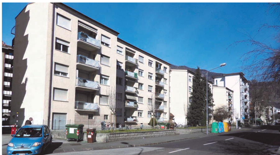
L'edificio di via Palermo prima e nella foto sotto dopo il rinnovo.
