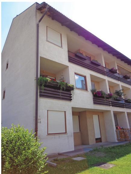
In alto l'edificio prima del risanamento a destra dopo l'intervento.
