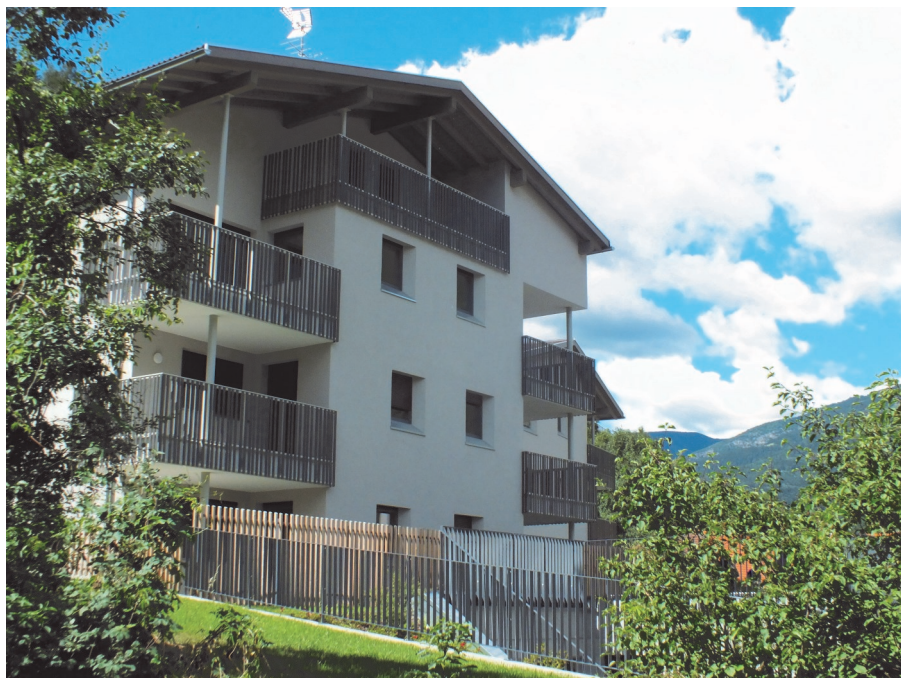
Das neue Gebäude mit 15 Wohnungen in Klausen/ Seebegg 42-44.
