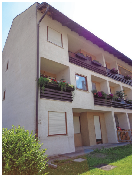
Oben das Gebäude vor der Sanierung, rechts nachher.
