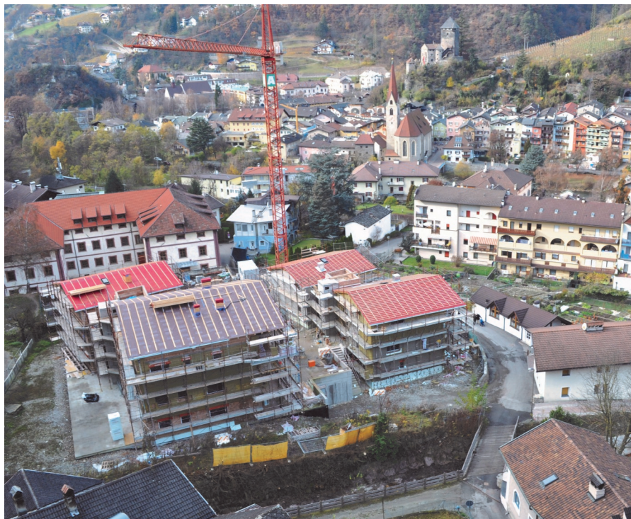
Eine Baustelle des Wohnbauinstitutes in Klausen.
