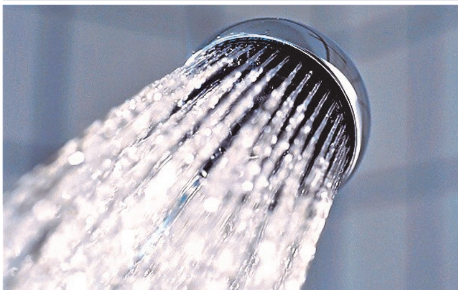
Schmutzige und verkrustete Duschbrausen unterstützen die Bildung von legionellenhaltigen Wassertropfchen.
