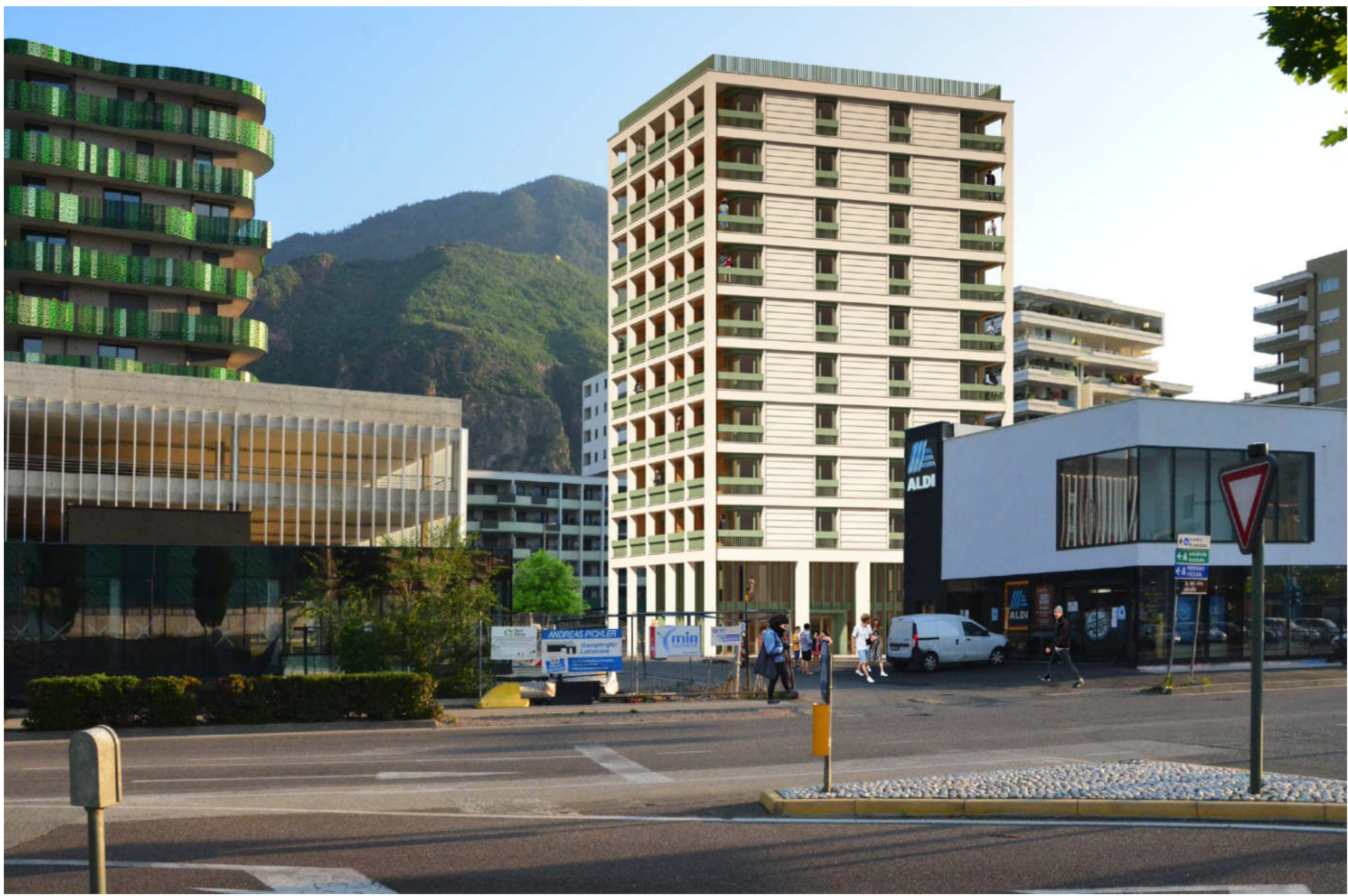
VISTA DA VIA DRUSO
