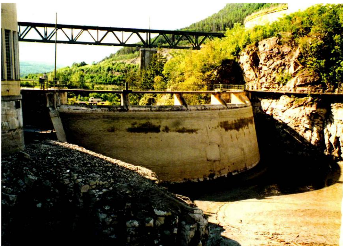
Figura 3: Foto della diga di Fortezza (fonte: FCEM)
