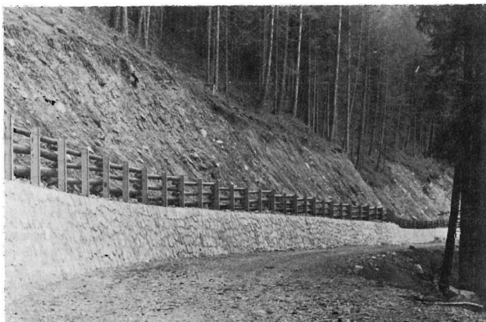
Bild 3: Forststraße St. Vigil-Enneberg mit hangseitiger Sicherung durch Steinschichtung Fotos: Archiv des Landesforstinspektorats
