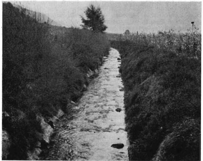
Unterlauf des Schlandraunbaches nach Verbauung in Trockenbauweise
