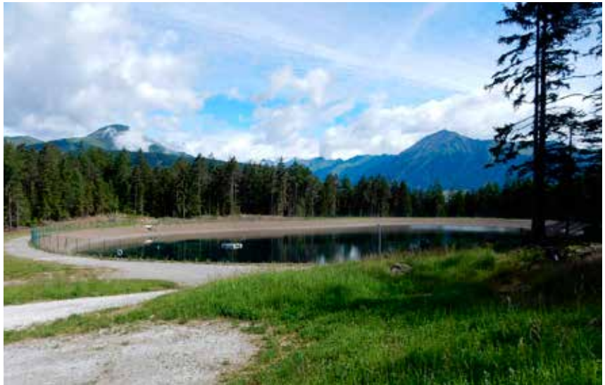
Speicherbecken in Rodeneck
