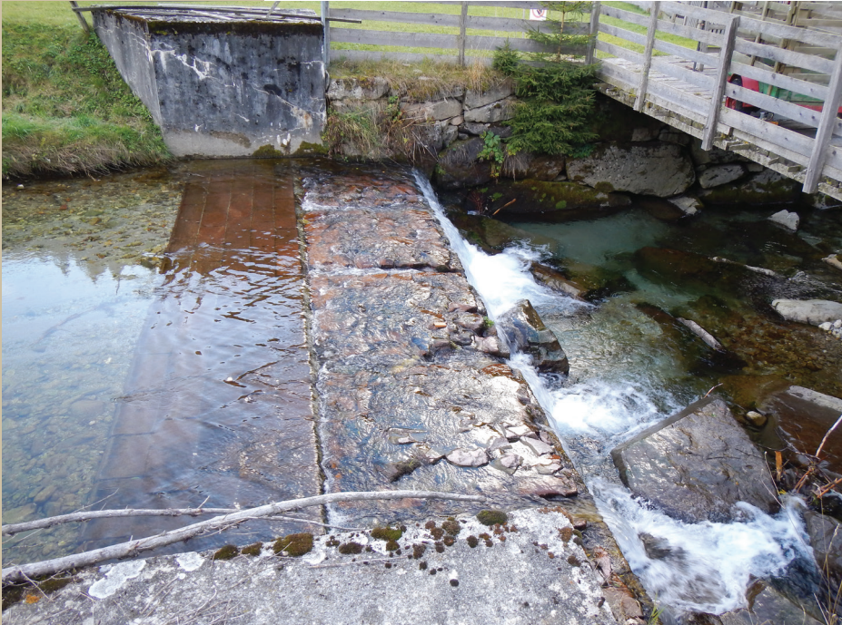
Fig. 14.2: Questo tipo di briglia rende difficile o impossibile la risalita del pesce lungo il corso d'acqua, limitandone così le possibilità riproduttive.
