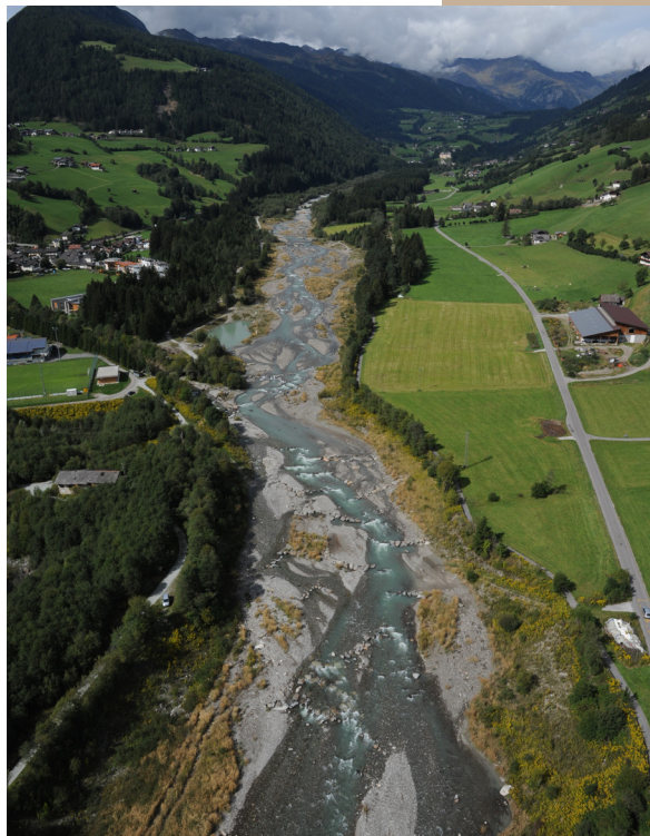
Fig. 15.2: Veduta aerea del Rio Mareta dopo l'intervento.
