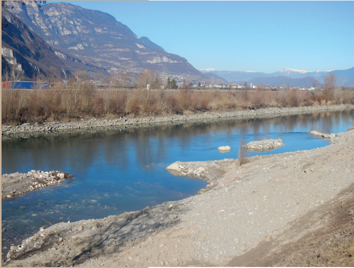
Abb. 15.4: Bieten Uferzonen ausreichend Raum, kann durch Buhnen das Strukturangebot des Flusses erhöht werden (Etsch).
