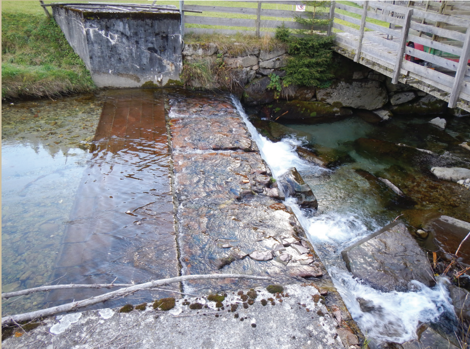
Abb. 14.2: Derartige Querbauwerke sind für flussaufwärts ziehende Fische unüberwindbar und können unter Umständen wichtige Laichzüge unterbrechen.
