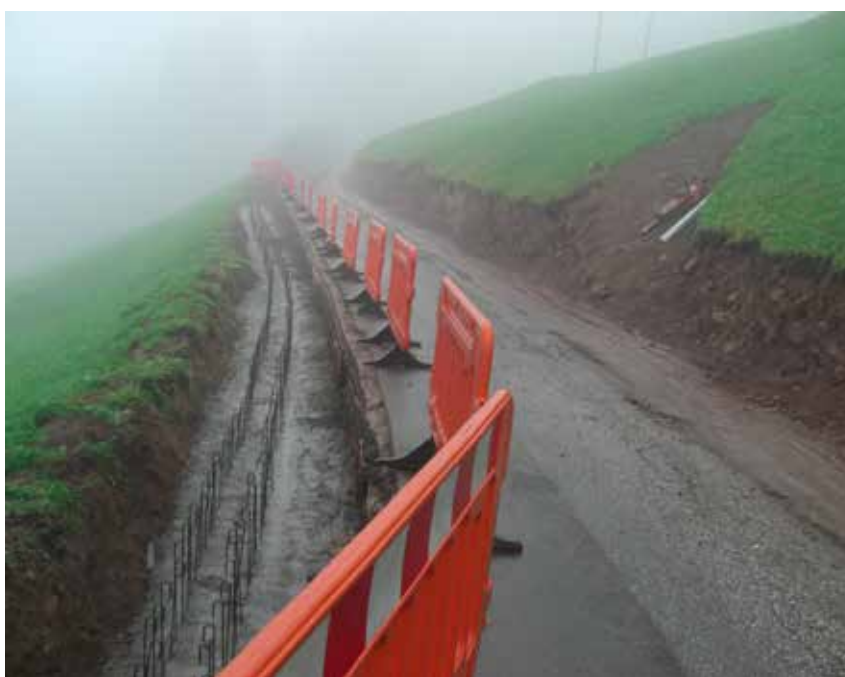
Eine gute und sichere Erreichbarkeit der Hofstelle ist Voraussetzung für die künftige Bewirtschaftung, im Bild der Mittereggshof im Schnalstal.
