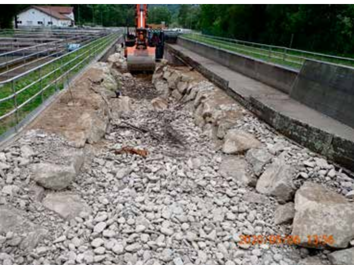
Der Betonfliesskanal während und nach dem Umbau
