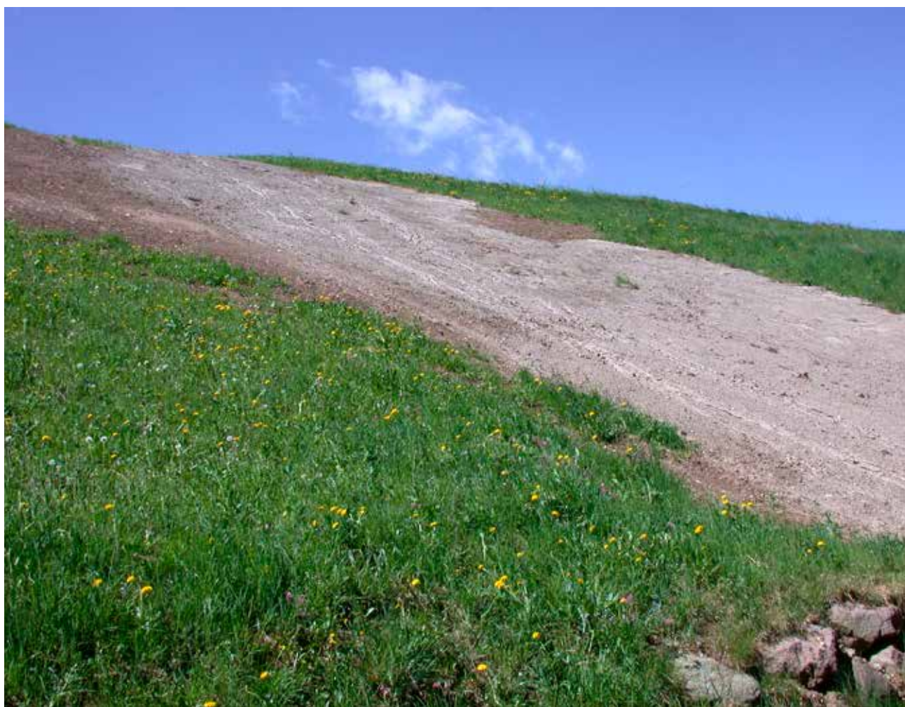
oben: Murbruch in einer Wiese ... unten: ... und nach der Behebung des Unwetterschadens.
