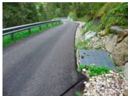
Gesicherte Böschungen und kontrollierte Längs- und Seitenentwässerung, erneuerter Fahrbahnaufbau samt Leitplanken. So sieht ein Straßenabschnitt des ländlichen Wegenetzes nach erfolgter Sanierung aus (bei Kandellen in der Gemeinde Toblach).
