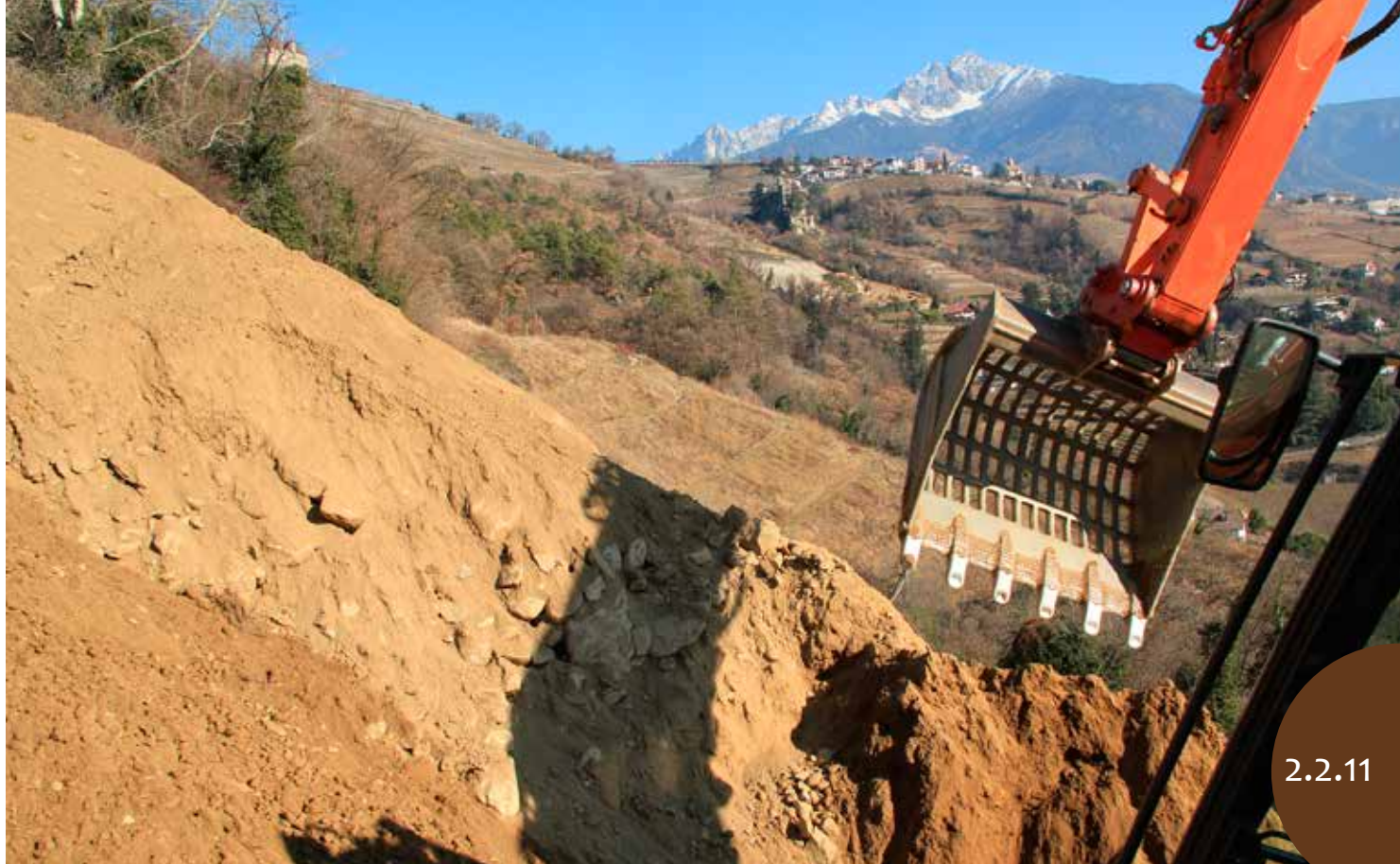
Erdbewegung mit einem Bagger
