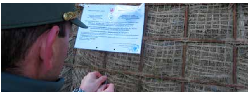
Gerichtspolizeiliche Tätigkeit: Vorsorgliche Beschlagnahme einer Baustelle im Auftrag der Staatsanwaltschaft.
