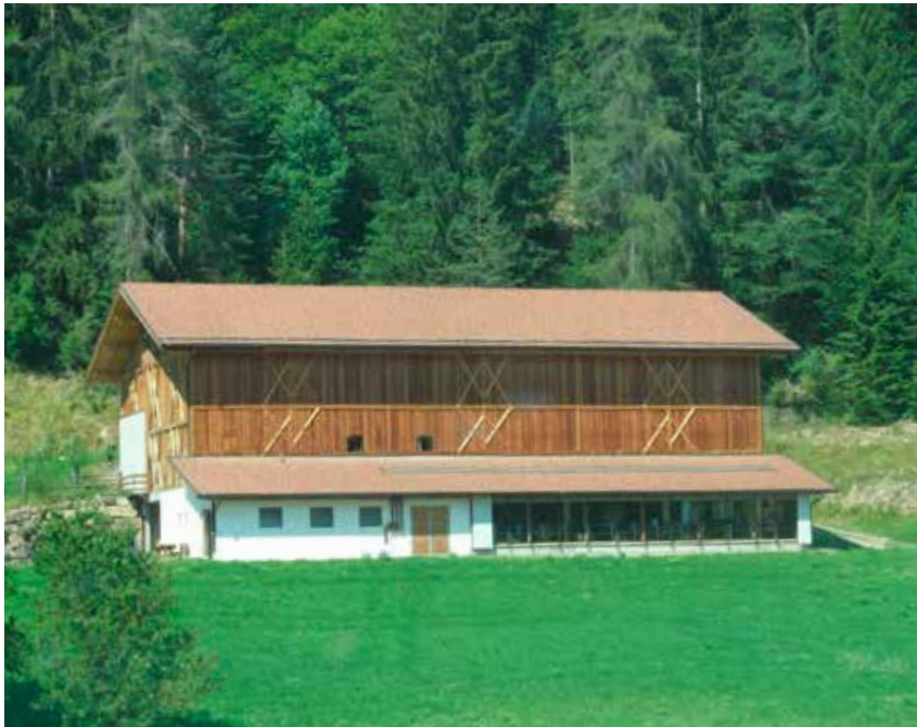
Neubau landwirtschaftliches Wirtschaftsgebäude
