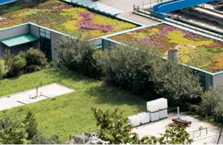
Kläranlage Bozen mit Gründach
