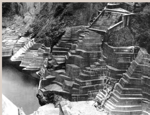
Consolidamento di pendio; sopra Saito City (J) Hangverbau; oberhalb Saito City (J)
