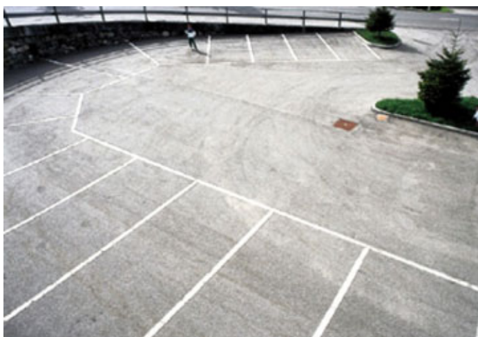
Sigillature su aree destinate alla viabilità
