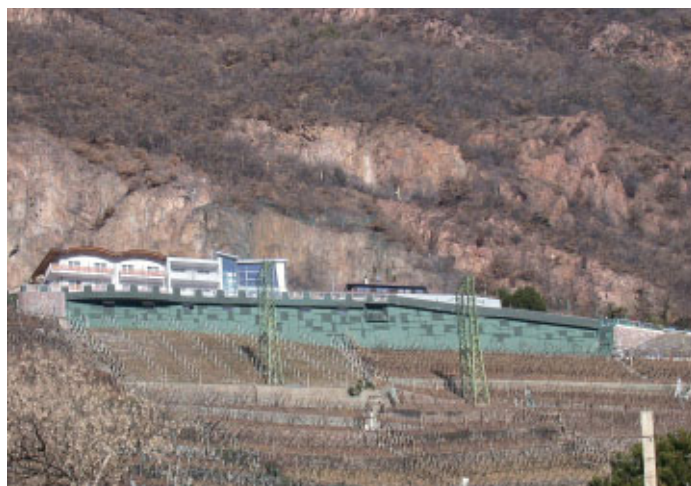
Bolzano: tramite costruzioni realizzate nel versante a terrazzamenti si possono evitare muri di sostegno imponenti. In inverno la mimetizzazione verde di muri e piloni risalta ancora di più. Inoltre anche il guazzabuglio dei tetti è un problema.
