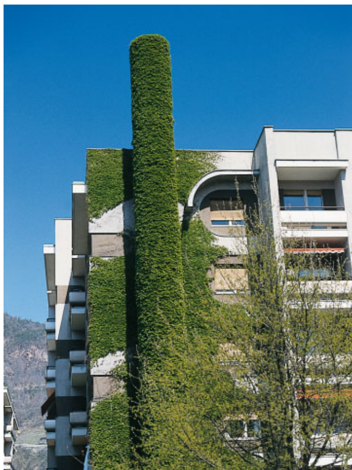
Persino mura di calcestruzzo possono trasformarsi in habitat, migliorando la qualità di vita ed il microclima degli insediamenti
