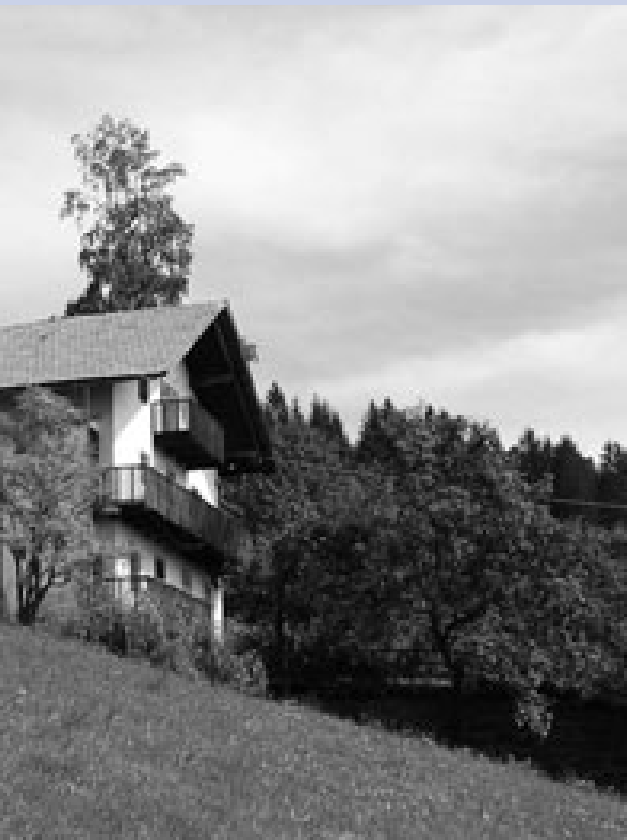
Bestand / Stato di fatto
