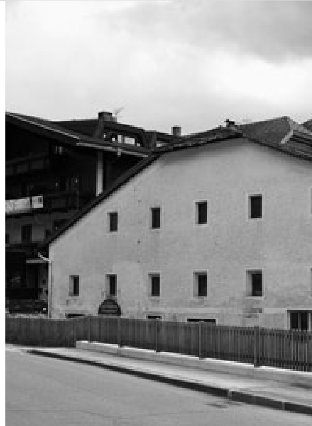
Bestand / Stato di fatto
