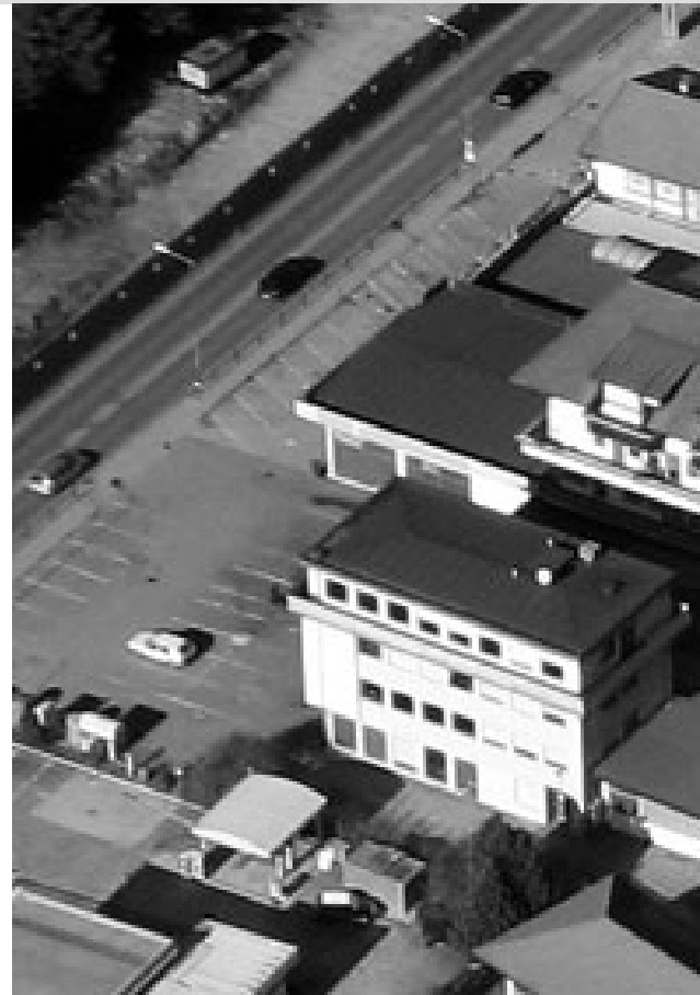
Bestand / Stato di fatto
