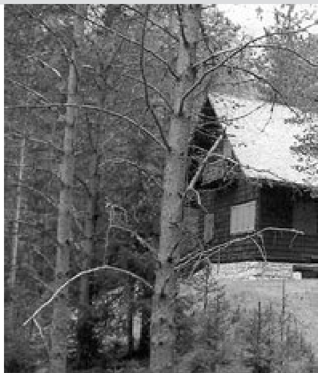
Bestand / Stato di fatto
