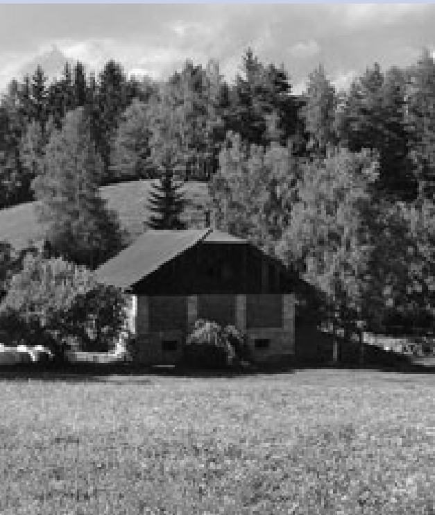
Bestand / Stato di fatto
