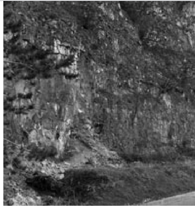
Bestand / Stato di fatto
