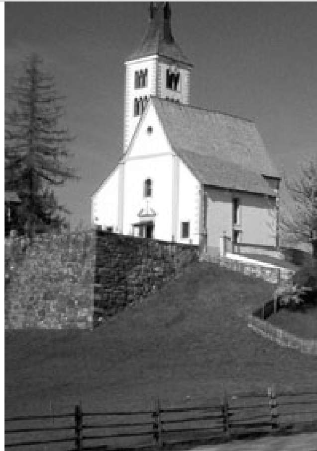
Bestand / Stato di fatto
