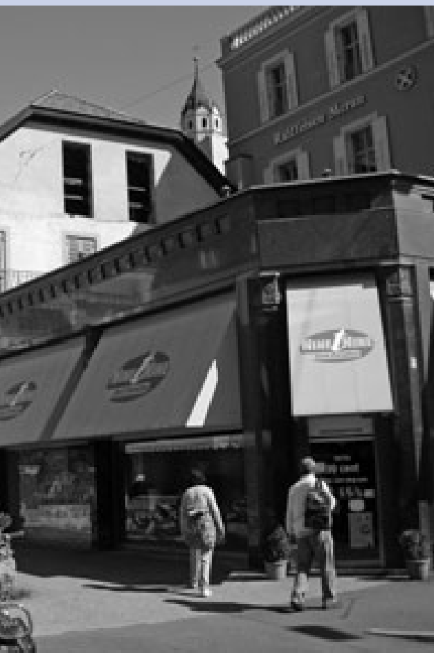
Bestand / Stato di fatto
