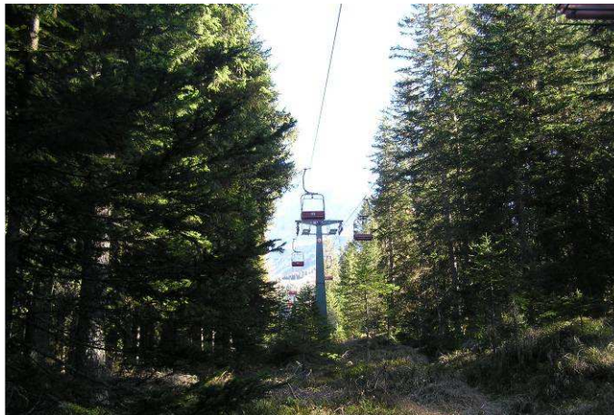
9.6 Liftanlage – Impianto di risalita
