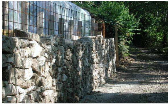
Bruchsteinmauer – Muri in pietra
