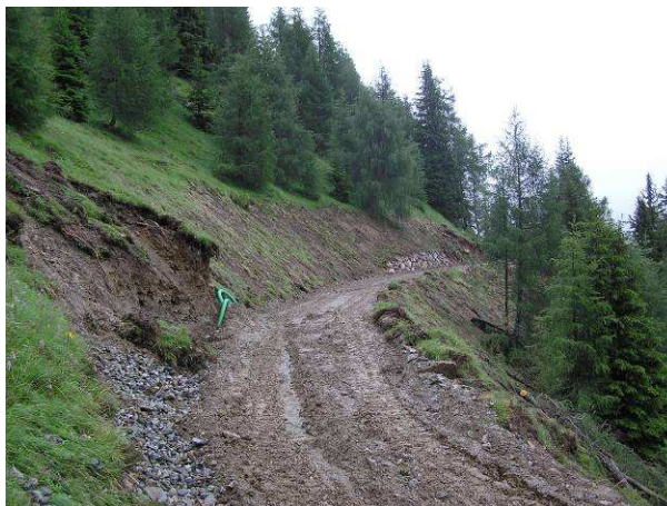
1.2 Bau einer Forststraße - Costruzione di una strada forestale
