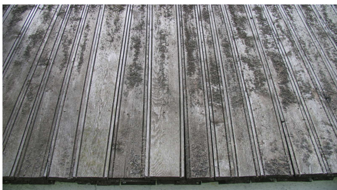
Bretterdach zweilagig verlegt – „Bretterdach“ a posa doppia
