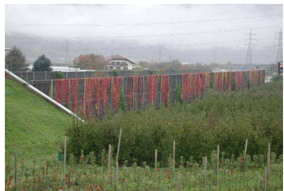
3.6 Lärmschutzwände - Barriere antirumore
