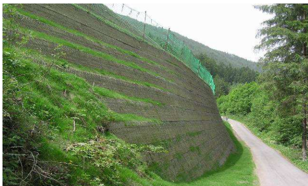
Bewehrte Erde – Terra armata
