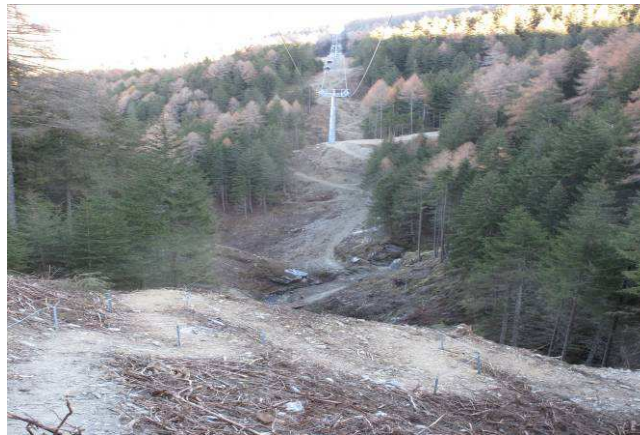
9.2 Liftanlage – Impianto di risalita
