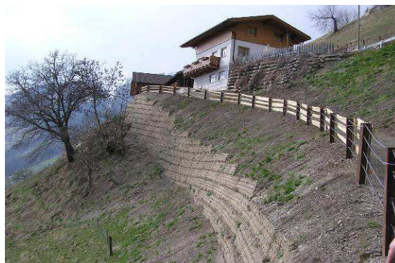
Bewehrte Erde – Terra armata
