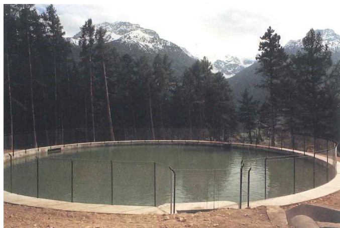
6.1 Beregnungsbecken in Beton - Bacino irriguo in cemento
