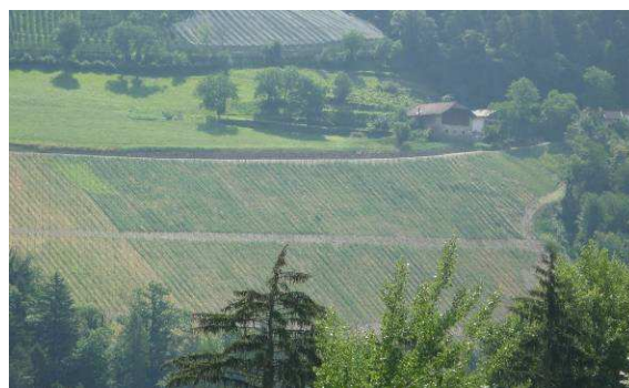
2.6 Planierung – Neuanlage Nach den Arbeiten - Spianamento – nuova coltura dopo i lavori
