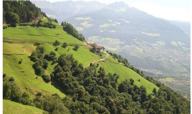
3.4 Hofzufahrt - Strada d'accesso al maso
