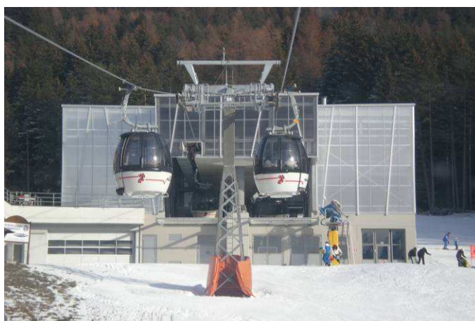
9.1 Talstation – Stazione a valle
