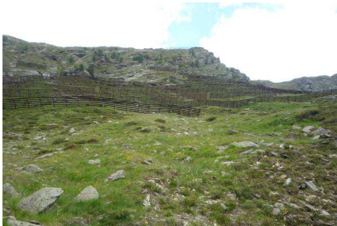
13.1 Lawinenverbauungen - Opere paravalanghe
