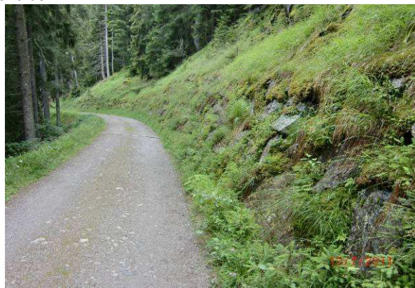
Zyklopenmauer begrünt – Muro ciclopico rinverdito
