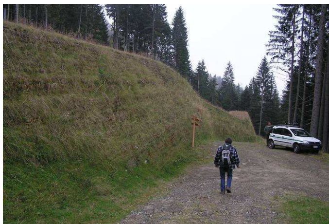
13.4 Steinschutzwall - Vallo paramassi
