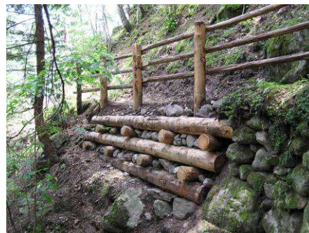
Holzkraierwand – Palificata in legname
