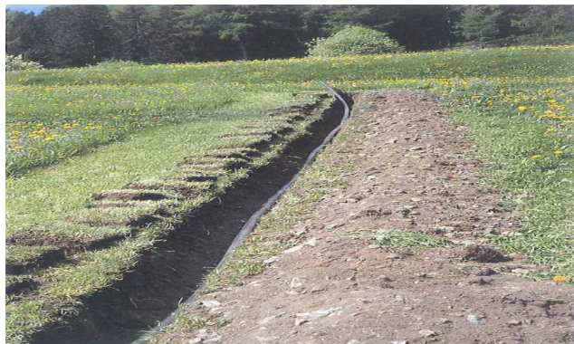
6.2 Verlegung der Wasserrohrleitung - Posa in opera di tubazioni
