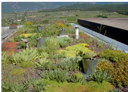
Dachbegrünung Tetto verde
