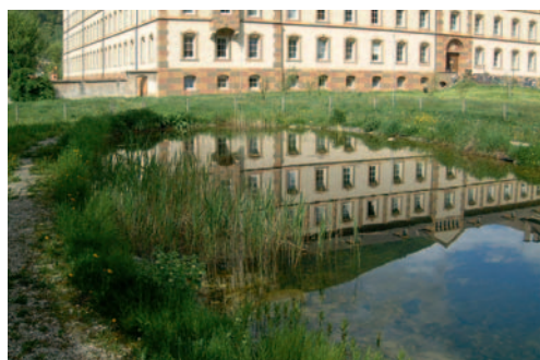
Freifläche am Vincentinum in Brixen Spazio aperto presso il Vincentino a Bressanone
