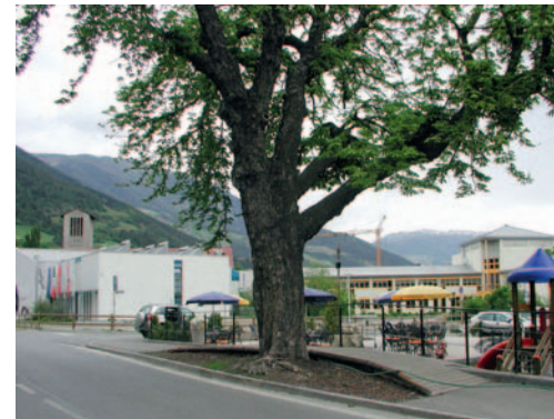
Der Baum wird durch eine Brücke über den Wurzelraum geschützt L'albero viene protetto da un elemento a ponte sull'apparato radicale
