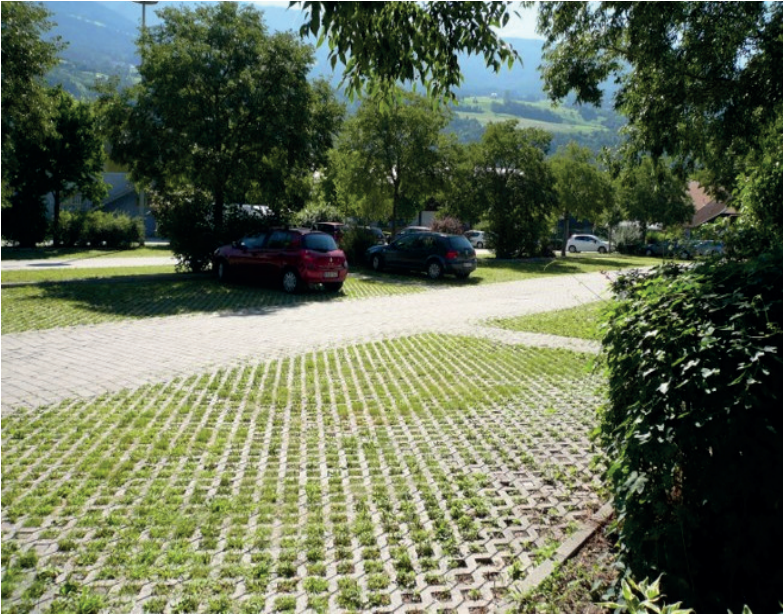
Bressanone: parcheggi permeabili e strade di accesso, nonché aree verdi di confine e di mezzo con piantumazione di alberi. Foto: Ufficio Pianificazione paesaggistica e comunale.
