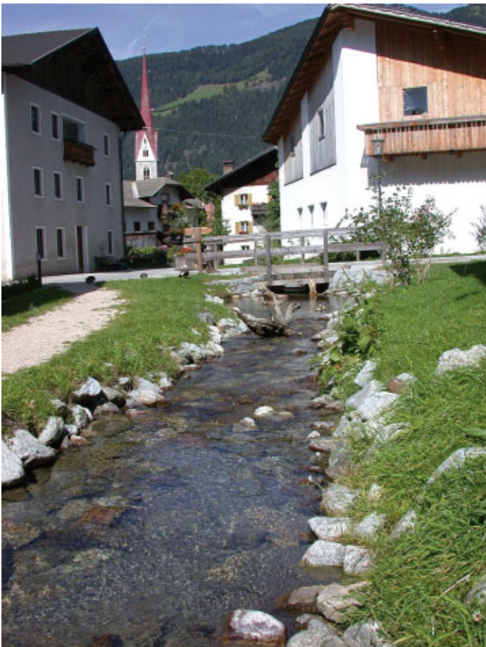
Renaturierung des verrohrten Dorfbachls von Stilfes
