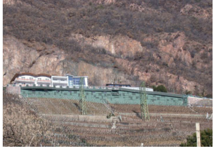
Bozen: Durch abgestuftes Bauen am Hang wären derart gewaltige Stützmauern vermeidbar. Durch ungeschickte „Grüntarnung“ fallen Mauern und Masten im Winter erst recht auf. Auch das Sammelsurium der Dachlandschaft ist problematisch.
