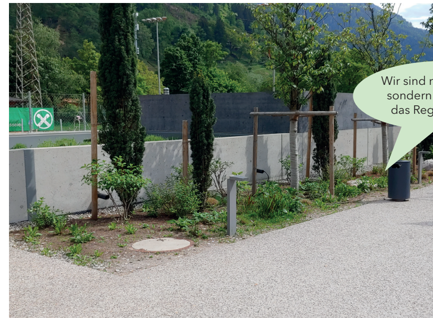
St. Martin in Passeier: Durch die Ausführung ohne Randstein kann das Niederschlagswasser der umliegenden Flächen in die Grünfläche gelangen und den Wasserabfluss in die Kanalisation reduzieren. Foto: Amt für Landschafts- und Gemeindeplanung.
