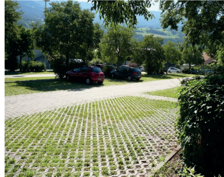
Brixen: Durchlässige Stellflächen und Zufahrtswege sowie begrünte Rand- und Mittelbereich mit Baumpflanzungen ausgeführt. Foto: Amt Landschafts- und Gemeindeplanung.
