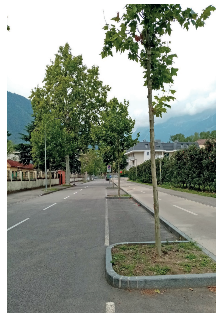
Merano: Rimozione della pavimentazione di alcune aree della fascia di parcheggio per la piantumazione di alberi. Foto: Comune di Merano.
