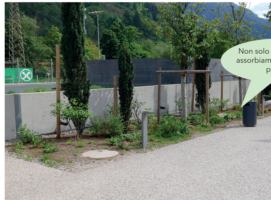
San Martino in Passiria: Grazie alla realizzazione senza cordolo, l'acqua piovana delle superfici circostanti può defluire nell'area verde, riducendo il deflusso verso la rete fognaria. Foto: Ufficio Pianificazione paesaggistica e comunale.
