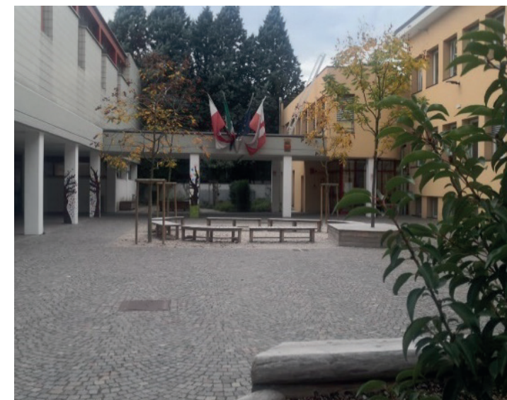
Bolzano: Riprogettazione di un cortile scolastico con superfici permeabili all'acqua, aree ricreative non sigillate con piantumazione di alberi nelle aree centrali e nelle aree verdi perimetrali. Foto: Ufficio Pianificazione paesaggistica e comunale.
