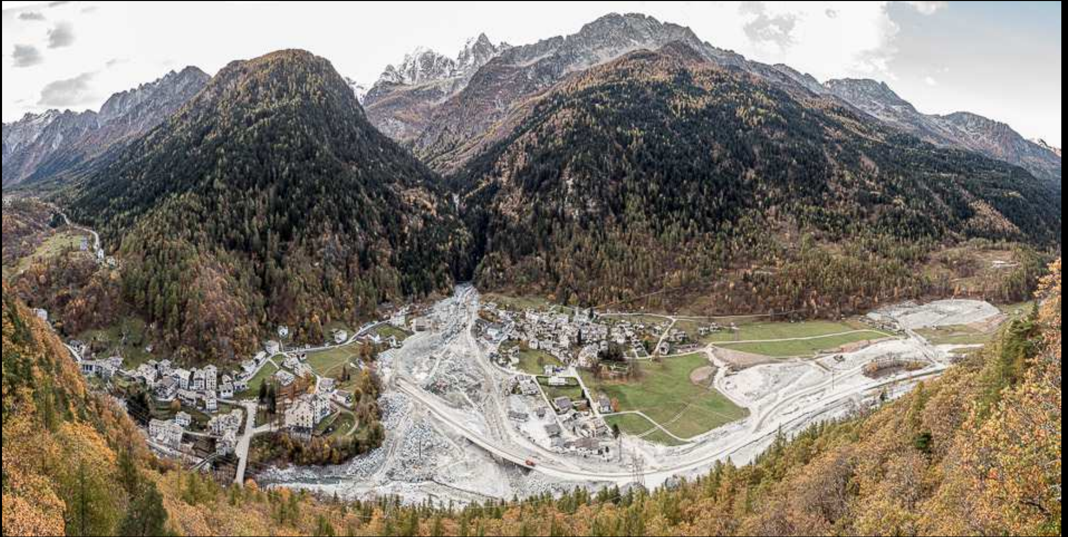
Bondo Wiederaufbau nach dem Bergsturz
