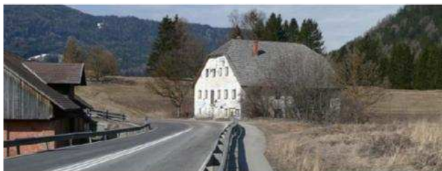
Bestand / stato di fatto
