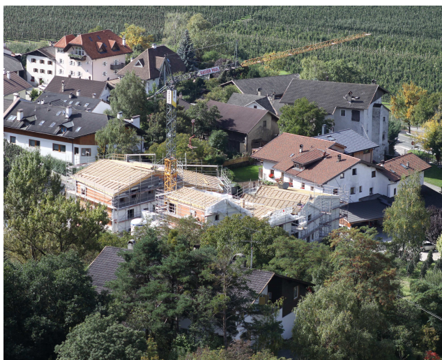
Wohnbauzone in Bau / zona residenziale in costruzione
