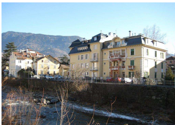
Bestand / stato di fatto
