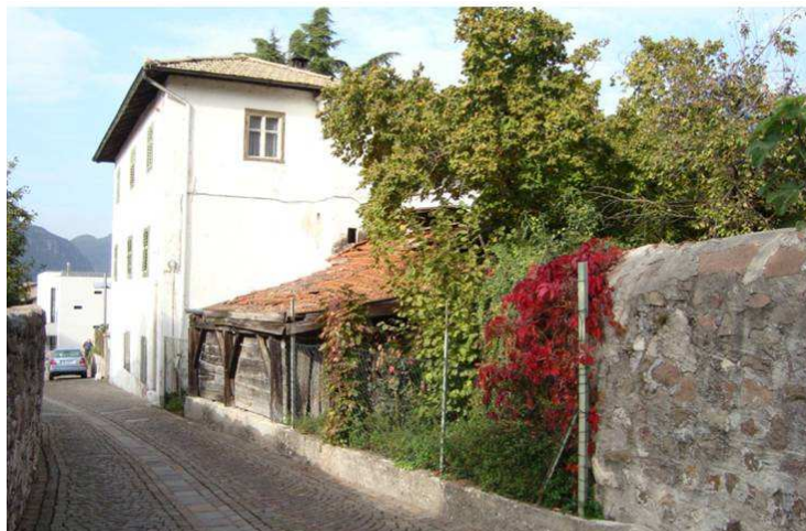
Bestand / stato di fatto
