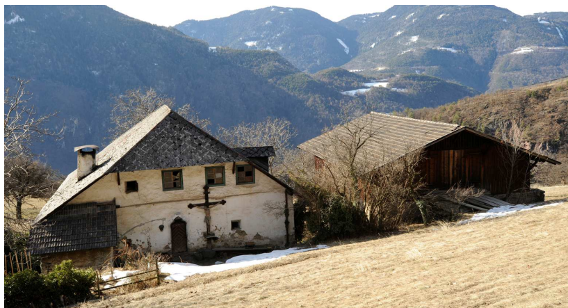
Bestand / stato di fatto
