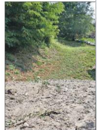
Die Mure gelangte bis auf das Freigele
