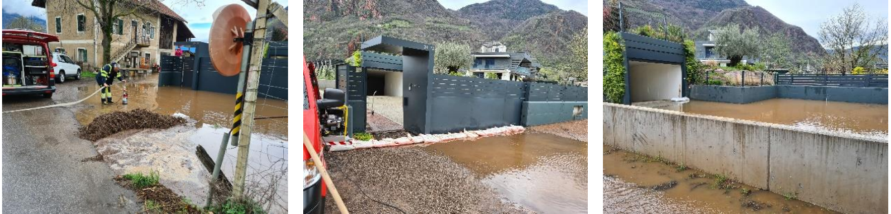
Abb. 4.7: Die pflanzlichen Ablagerungen, die sich in den Gräben am Talboden ansammeln, können zum Verstopfen von Durchlässen und in der Folge zu Überschwemmungen führen. Auch wenn solche Ereignisse durch begrenzte Wasserstände und Fließgeschwindigkeiten gekennzeichnet sind, können sie erhebliche Schäden an Gebäuden verursachen, insbesondere an Kellergeschossen, wenn diese nicht ausreichend geschützt sind.
