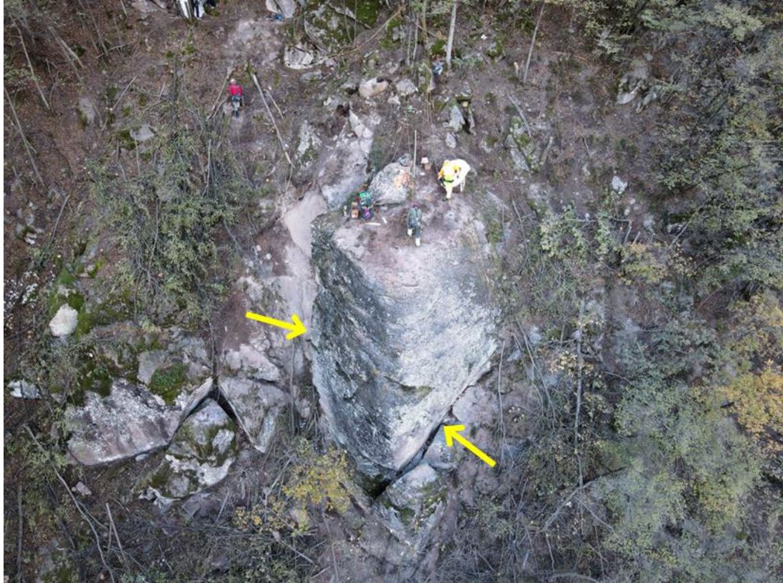
Abb. 5.23: Luftaufnahme der freigelegten Felsnase mit einem Volumen von ca. 550 m 3 . Gut zu erkennen im unteren Bildbereich die subvertikalen, offenen Klüfte (gelbe Pfeile) der vulkanischen Gesteine.
