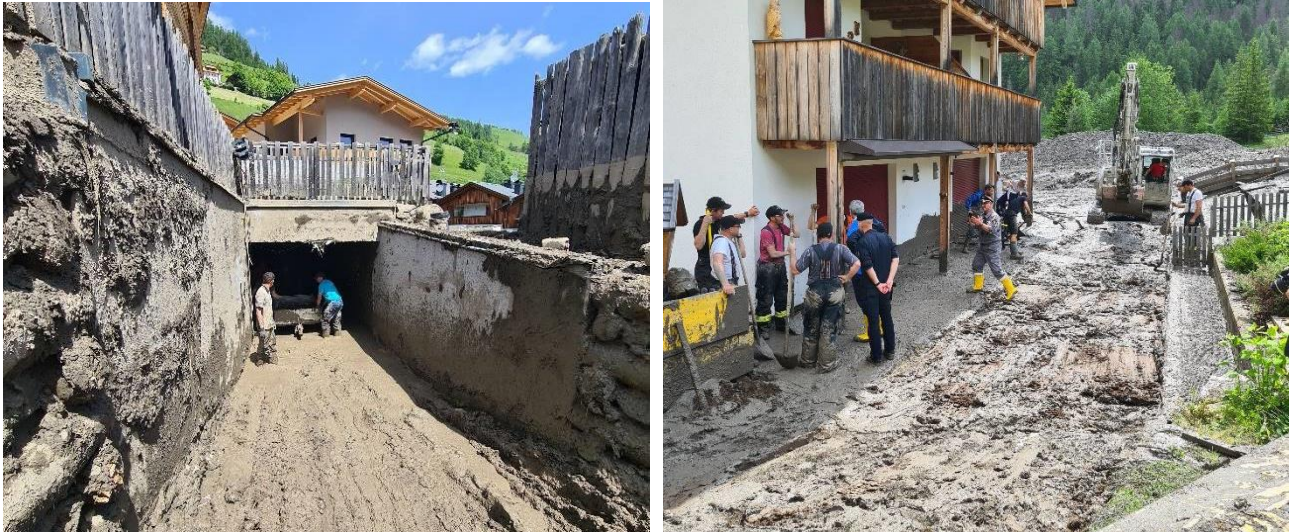
Abb. 4.11: Die Mure im Bereich des Seresbaches trat im Abschnitt, der durch das Dorf verläuft, über die Ufer und verursachte erhebliche Schäden. Der Ablauf des Ereignisses ermöglichte die rechtzeitige Evakuierung der am stärksten gefährdeten Gebäude.
