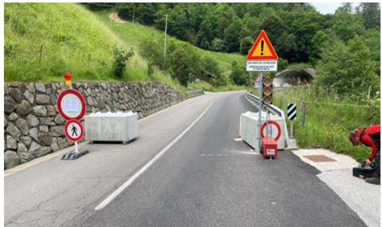
Abb. 5.13: Monitoringsystem mittels Doppler-Radar und Überwachungskameras (links und rechts oben im Bild) und automatische Ampelregelung auf der LS. 3 (rechts unten im Bild).
