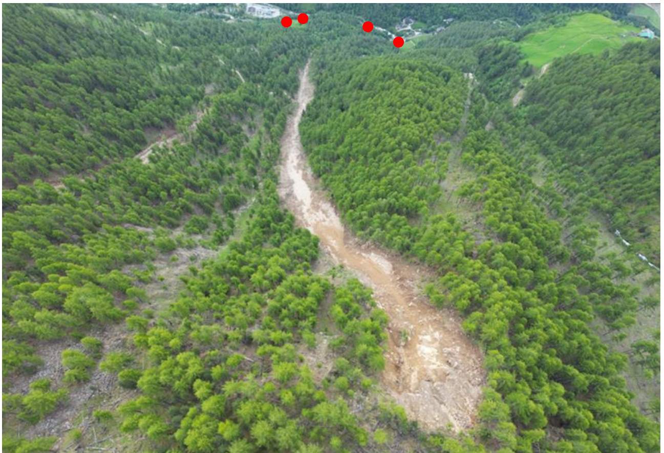
Abb. 5.10: Blick aus der Luft auf den Glorgraben: Anbruchnische, Sturzbahn und Stillstandspunkte der Sturzblöcke (rote Punkte).
