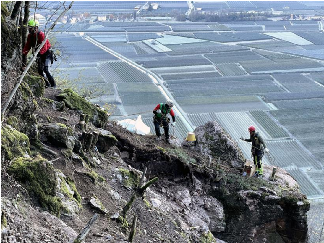
Abb. 5.24: Vorbereitung der Sprengung: Die Sprengsätze werden vom Sprengmeister und seinen Mitarbeitern fachmännisch deponiert, im Vorfeld der Sprengung wurden Bäume gerodet, um den Zugang zur Felsnase zu erleichtern.
