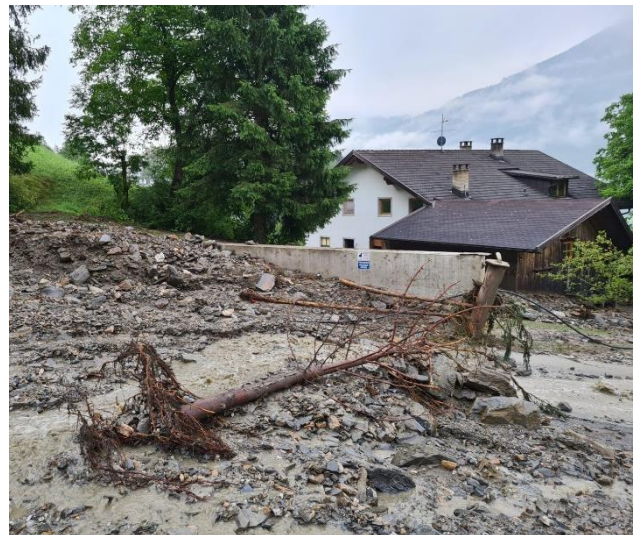
Abb. 4.13: Die intensiven Niederschläge lösten zahlreiche flachgründige Rutschungen auf den steilen Wiesenhängen und den Böschungen entlang der Straße nach Partinges aus. Das mitgeführte Material wurde in den Kirchgraben eingetragen, wo es teilweise von den neu errichteten Schutzmauern des Amtes für Wildbach- und Lawinenverbauung Nord zurückgehalten wurde.
