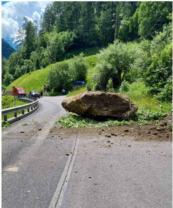
Abb. 5.8: Wegen des Felssturzes vom 5. Juni bleibt die Straße ins Schnalstal länger gesperrt. (LPA/Straßendienst)
