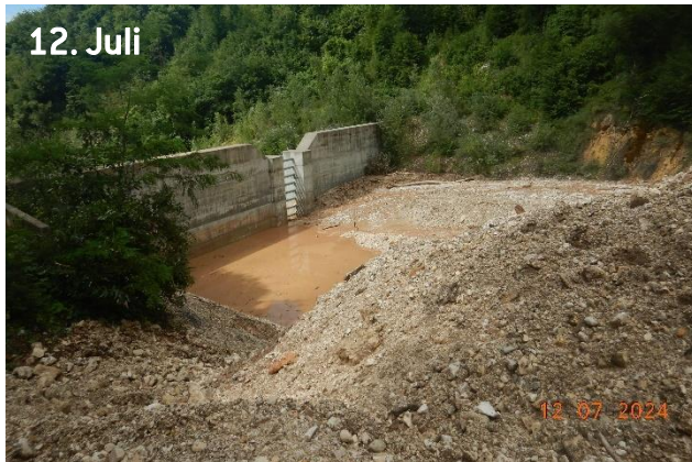
Abb. 4.9: Das Rückhaltebecken, das 2019 von den Technikern und Arbeitern des Amt Wildbach- und Lawinenverbauung Süd fertiggestellt wurde, hat nahezu die gesamte Menge der durch die drei Ereignisse im Jahr 2024 mobilisierten Sedimente zurückgehalten. Das Bauwerk verringert die Gefährdung durch den Montanerbach erheblich, der unterhalb der Anlage direkt an zahlreichen historischen Gebäuden des Dorfes vorbeifließt.
