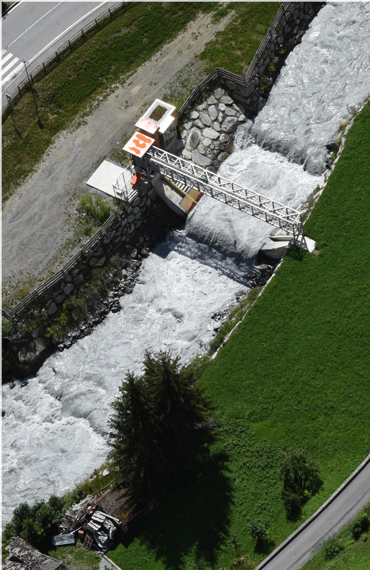
Pegelmessstelle Stilfser Brücke – Stilfs
