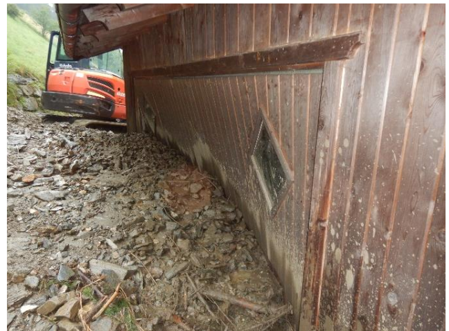
Abb. 4.14: Neben der klassischen Ereignisdokumentation wurde in Maria Trens eine gezielte Untersuchung durchgeführt, um die verschiedenen Mechanismen zu identifizieren, durch die hydraulische Prozesse Bauschäden verursachen können.
