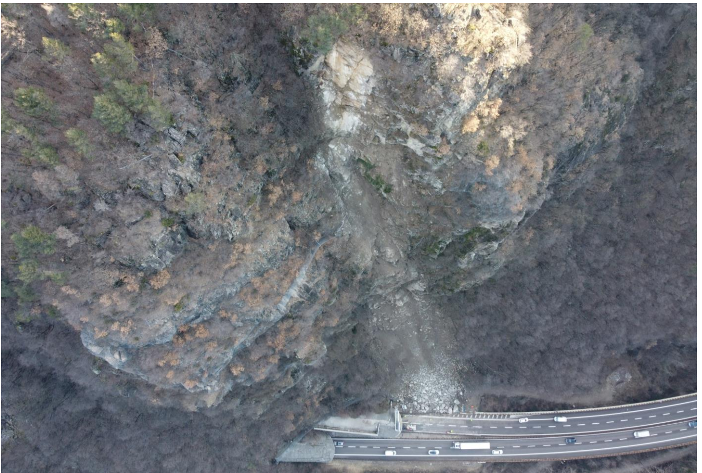
Abb. 5.4: Die Fotos zeigen verschiedene Arten von Massenbewegungen. Links oben eine Rutschung längs der LS.105 bei km 5+610 (Landesstraße Mals-Matsch), die sich am 2. Juni 2024 ereignet hat. Rechts oben im Bild ein Felssturz auf die Handwerkerzone Süd-Ost in der Gemeinde Auer, wo sich am 1. April 2024 einige 100 m 3 Porphyrgestein aus der Felswand gelöst haben und bis in die Handwerkerzone gestürzt sind. Das untere Bild zeigt hingegen den Felssturz auf der Nordspur der Autobahn A22 bei km 65+100 am 29. Jänner 2024. Deutlich erkennbar die Abbruchnische im Bereich der vertikalen Felswand sowie den Transit- und Ablagerungsbereich der Sturzblöcke mit Einzelblockvolumina von bis zu 8 m 3 .
