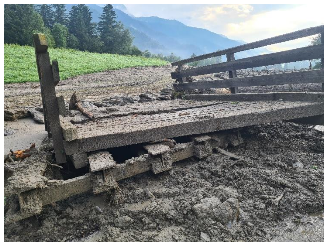
Abb. 4.18: Erosionserscheinungen und Schäden an Durchlässen am Langstaudenbach (B.605.100, Ereignis 2024062), angrenzend an den Überwasserbach.
