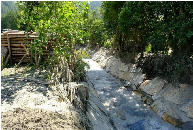
Abb. 4.17: Die Ablagerung von Holz oder Materialien in den Bereichen nahe den Bachläufen ist äußerst gefährlich, da Baumstämme und Heuballen Verstopfungen und Überflutungen verursachen können, die zu Schäden an Durchlässen und Infrastruktur führen.
