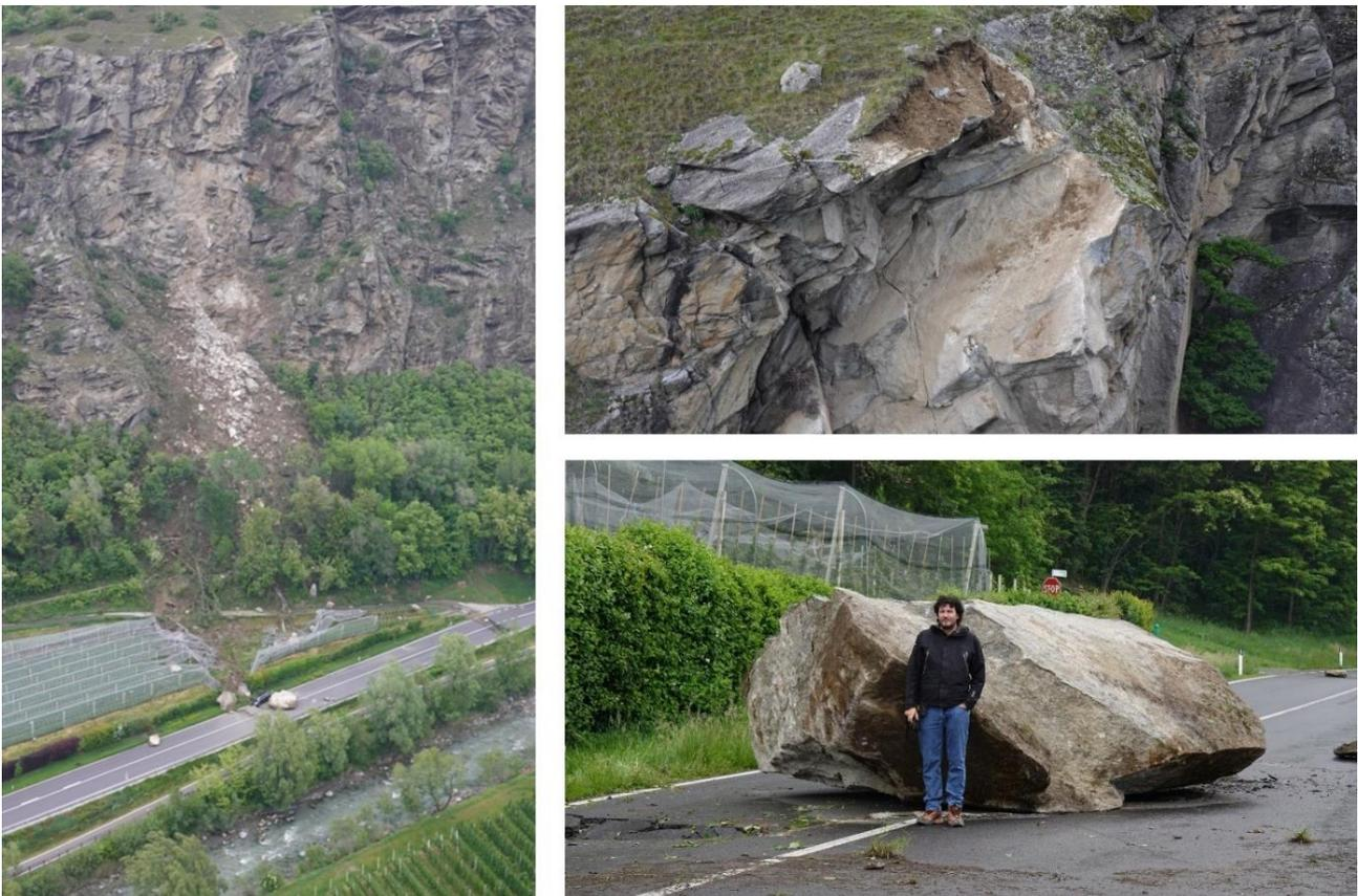
Abb. 5.8: Felssturz auf die Staatstraße38 bei km 172+250 bis km 172+380. Luftbildaufnahme des Abbruchbereichs, der Sturzbahn und des Ablagerungsbereichs, aufgenommen am Morgen des 22. Mai; Luftbildaufnahme der Abbruchkante auf 770 m ü.d.M; Foto des größten Sturzblocks mit einem Volumen von ca. 30 m<sup>3</sup> (1,9 x 4 x 4 m), der bis auf die Fahrbahn der Staatstraße 38 gestürzt ist.
