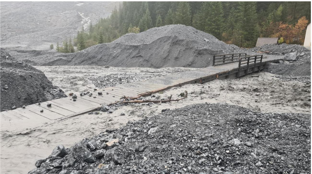
*Abb. 4.20: Am 20. Oktober hat ein weiteres Wetterereignis die Remobilisierung des Materials und einen neuen Schaden an der Brücke verursacht*
