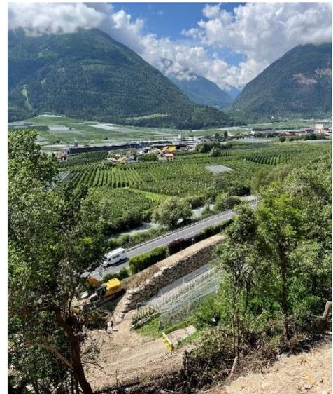
Abb. 5.11: Arbeiten höchster Dringlichkeit zur Realisierung des Steinschlagschutzdammes im Bereich der Vinschgauer Staatsstraße
