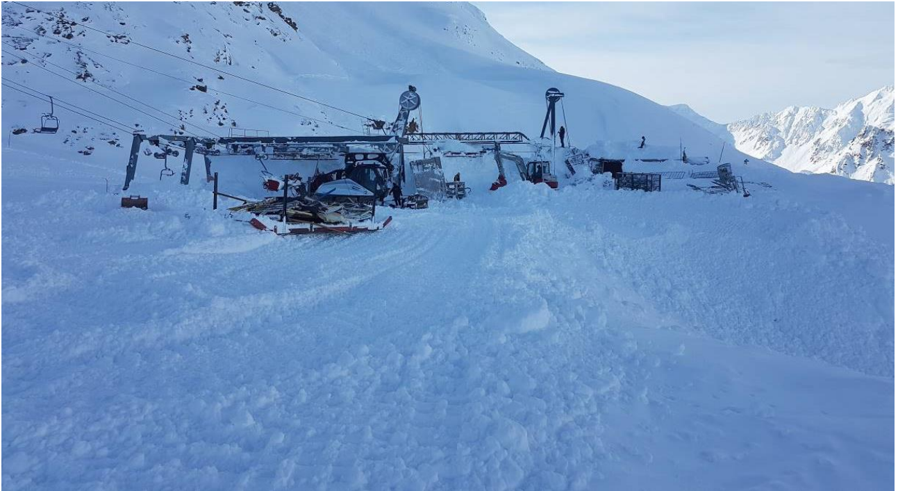
Figura 42: Dalle pareti rocciose esposte a nord della Croda grigia si è staccato, nelle prime ore della mattina del 15 novembre, un lastrone largo 150m che ha sepolto, con altezze di neve maggiori di 4m, la stazione a valle dell’impianto “Gletscher 1 e 2”
