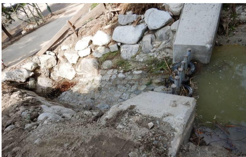
Figura 18: A sx, il tombone dopo le operazioni di sgombero. Seppur sufficiente per smaltire le piogge ordinarie; a dx il fronte della colata nel paese
