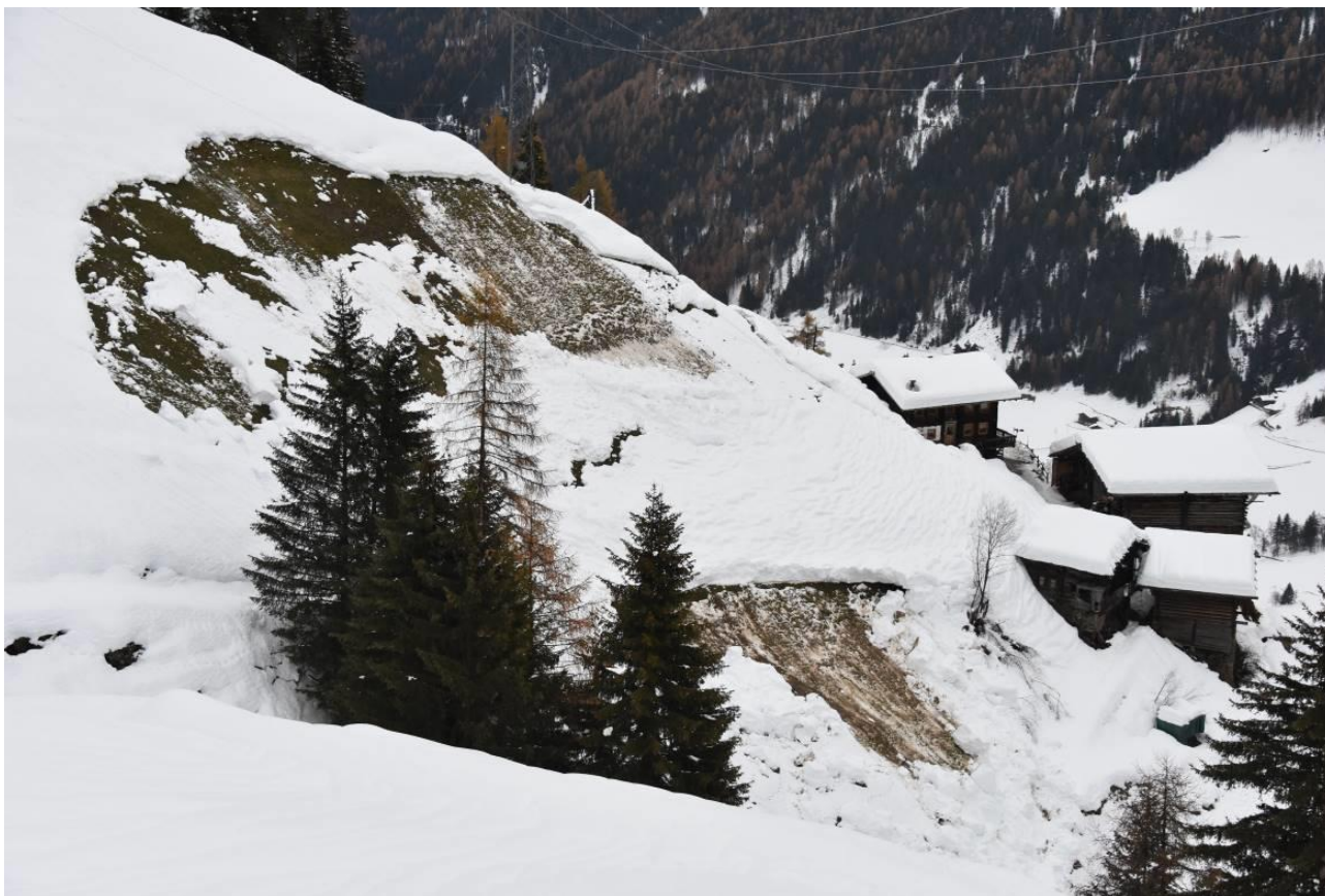
Figura 63: edificio accessorio al maso Niederstein sfiorato da uno slittamento di neve
