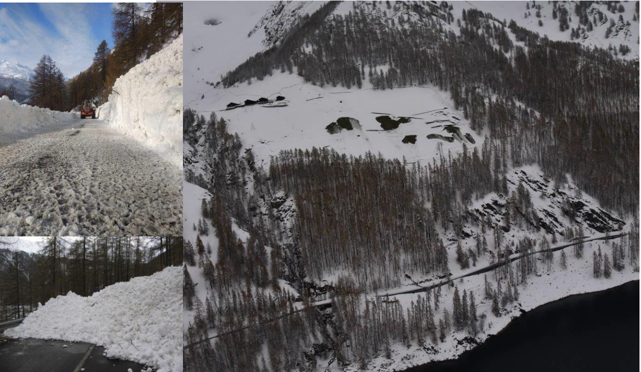
Figura 47: Valanghe di slittamento dai prati dei masi „Finail“ con interessamento della strada provinciale n. 3
