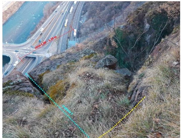
Figura 35: In alto a sx a dx, l'ammasso roccioso instabile a monte della strada statale nella zona del Virgolo, con un volume stimato di circa 300 m 3 . A causa dei cicli di gelo-disgelo e soprattutto a causa delle forti piogge del novembre 2019, le condizioni di stabilità del cuneo roccioso si erano gravemente deteriorate, tanto da rendere urgente l'operazione di brillamento
