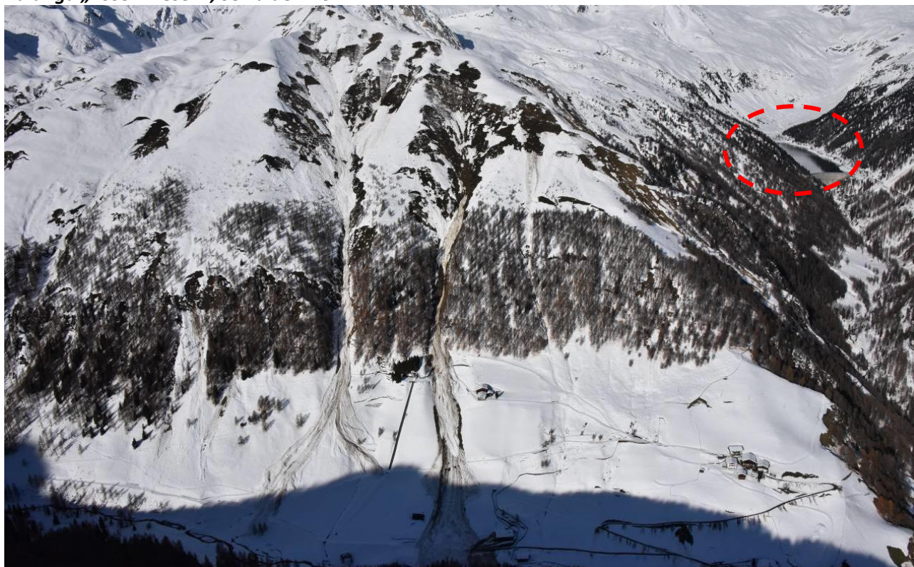
Figura 50: valanghe di slittamento „Oberhof“ e „Zösenberg“ a Lappago con in alto a destra il lago della diga di Neves non ancora completamente gelato
