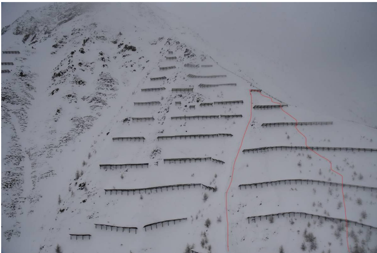
Figura 44: una parte della neve fresca caduta è scivolata attraverso i pontili in acciaio dell'esistente sistemazione
