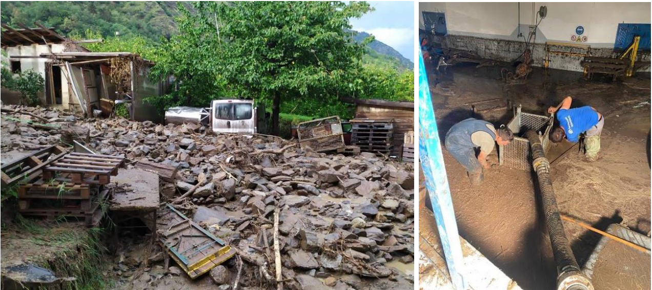
Figura 21: A sx, i depositi della colata nel cortile; a dx le operazioni di sgombero del fango dall’officina. I danni arrecati ad attrezzatura e macchinari sono ingenti
