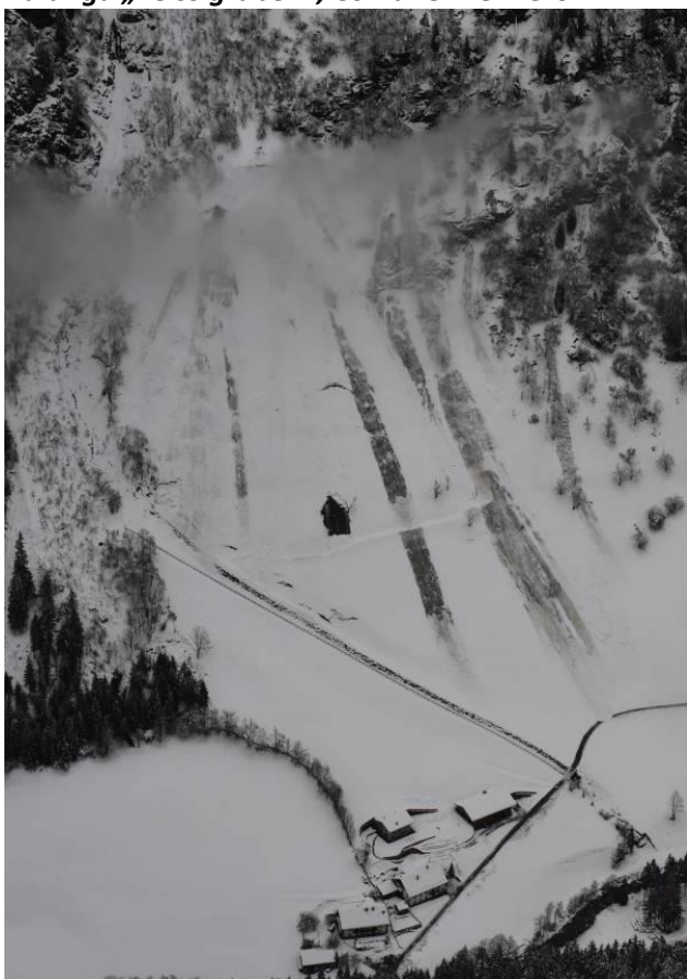
Figura 58: nell'immagine a sinistra si nota l'argine di deviazione della valanga "Teisslgraben" in val di Fleres e nell'immagine a destra i lavori di sgombero della neve accumulata a ridosso dell'argine stesso
