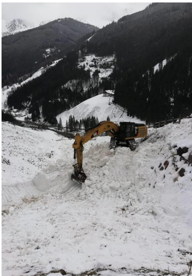
Figura 58: nell'immagine a sinistra si nota l'argine di deviazione della valanga "Teisslgraben" in val di Fleres e nell'immagine a destra i lavori di sgombero della neve accumulata a ridosso dell'argine stesso
