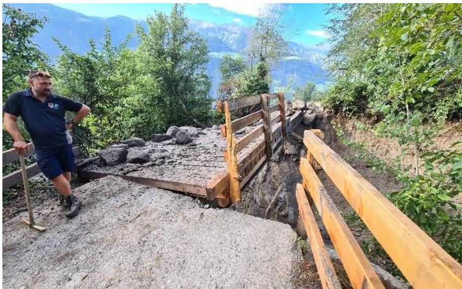
*Abb 4.12: Verzeichnete Schäden an den Übergängen: In Fließgewässern mit hohem Feststofftransport kann es häufig zu einer Verklauung kommen. Die Bewertung dieses Risikos ist daher sowohl bei der Bewertung der Gefahr als auch bei der Planung von Bauwerken und Infrastrukturen stets zu berücksichtigen.*
