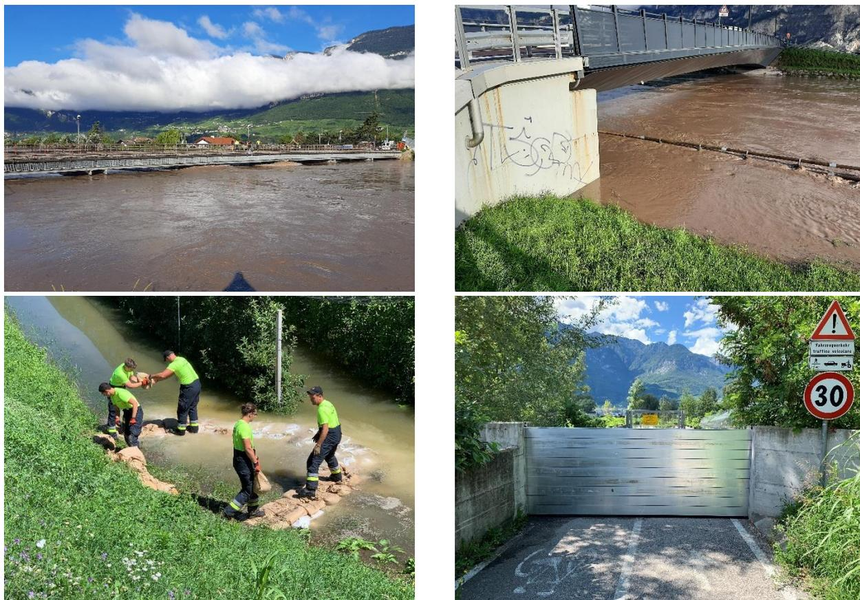
*Figura 4.23: in alto a sinistra: il ben noto punto critico in corrispondenza del ponte di Egna. In alto a destra; in basso a sinistra, l'intervento dei vigili per contenere i fontanazzi; in basso a destra: come misura precauzionale è stata montata la barriera mobile sulla ciclabile a monte di Egna, in sinistra orografica*
