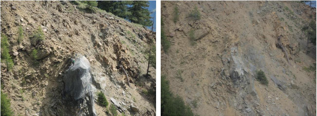
Figura 5.11: Prima del brillamento, la porzione superiore del Kastenknott è stata rivestita con reti metalliche, per limitare la dispersione incontrollata dei frammenti rocciosi
