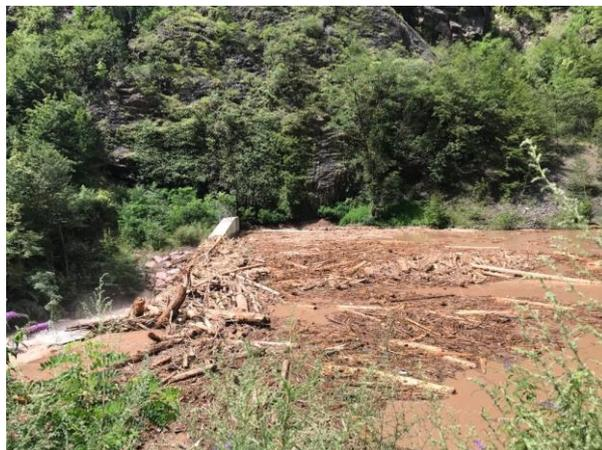
Figura 4.10: l'azione filtrante prodotta dalla briglia a monte di Bolzano in località Sill (a sinistra in occasione dell'evento del 18 giugno, a destra del 5 agosto)
