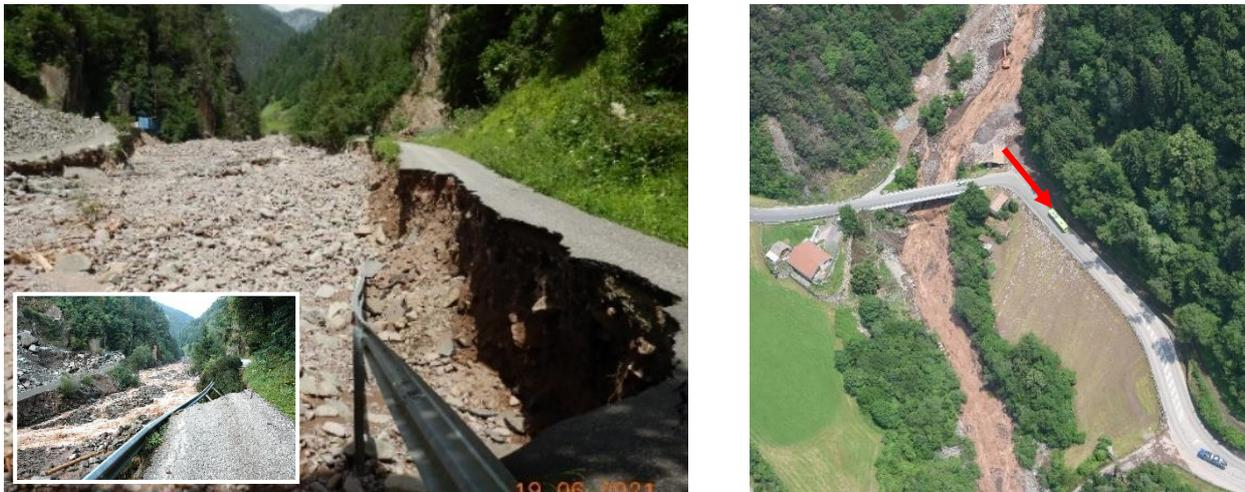
Figura 4.8: a sinistra, la piena ha eroso quasi completamente la sede della strada di accesso ai masi (nel riquadro l'analogo fenomeno del 2009); a destra: in corrispondenza del ponte sulla SP, il Rio Danza è esondato in sinistra orografica alluvionando la sede stradale ed i prati sottostanti
