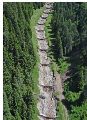
Figura 4.7: a sinistra e al centro: le precipitazioni intense, accompagnate da grandine, hanno generato nuove erosioni che aumentano la disponibilità di detrito del bacino. Tali processi sono piuttosto difficili da valutare nelle analisi della pericolosità idraulica. A destra: la scalinata di briglie realizzate dai Bacini montani nella parte intermedia del bacino ha limitato l'erosione dell'alveo
