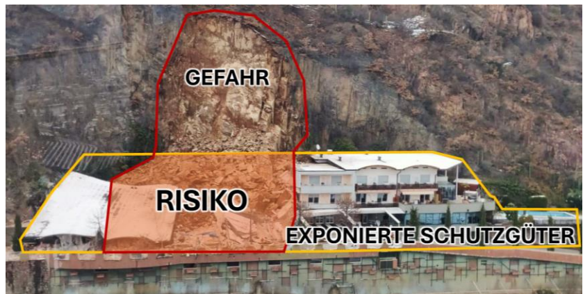
ABB. 1: Risikokzept; Felssturz beim Hotel Eberle 2021 - Beispiel für eine räumliche Darstellung des Risikokzeptes: Das Risiko hängt von der Überlappung der Gefahr H (Sturz) und den exponierten E und verwundbaren Vermögenswerten V (Hotel) ab. R = H \times E \times V
