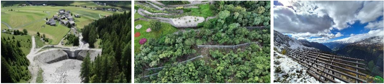
ABB. 6: Beispiele für Gefahrenminderungsmaßnahmen. Von links: Filtersperre (Gsies), Steinschlagschutzzäune (Meran, Trauttmansdorff), Schneebrücken (Schnals)
