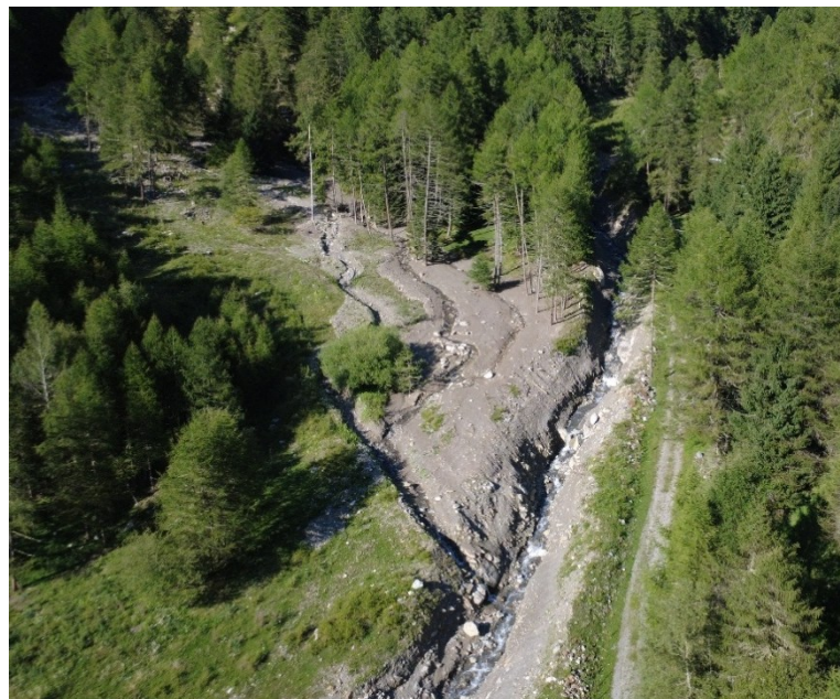
Figura 4.15 – Foto area della sezione di chiusura del quarto sottobacino
