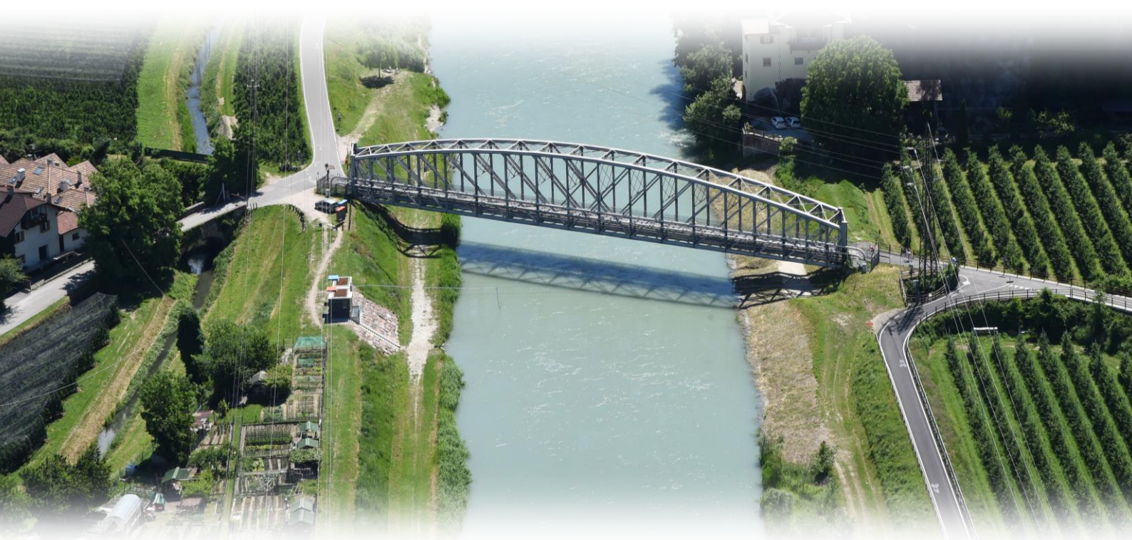
Idrometro a Ponte Adige – Bolzano
