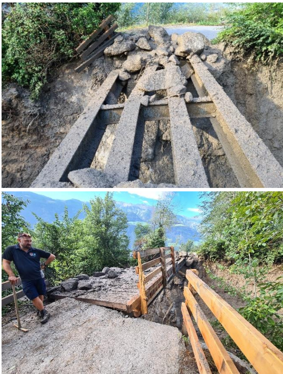
Figura 4.12: Danni agli attraversamenti: in corsi d'acqua con elevato trasporto solido l'occlusione è un fenomeno estremamente probabile, che va quindi sempre considerato sia nella valutazione del pericolo e nella progettazione di opere e manufatti
