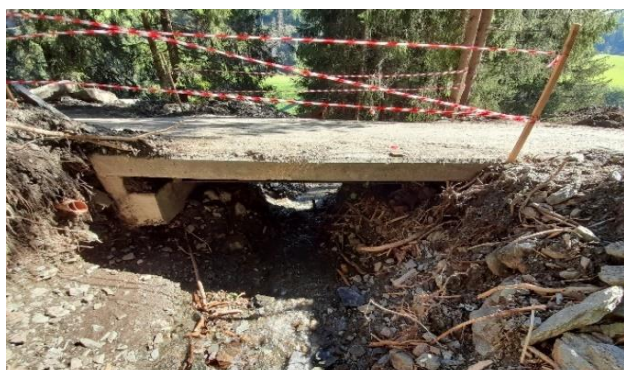
Figura 4.19: A sx il ponte sulla strada forestale Cianacei la cui occlusione ha causato l'esondazione in destra e sinistra del rio. A destra i detriti che hanno raggiunto la struttura alberghiera.
