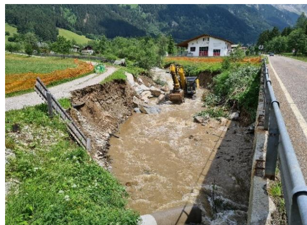
Figura 4.11: L'alluvione torrentizia sul Rio di Anterselva ha provocato fenomeni localizzati di esondazione e diffuse erosioni laterali.
