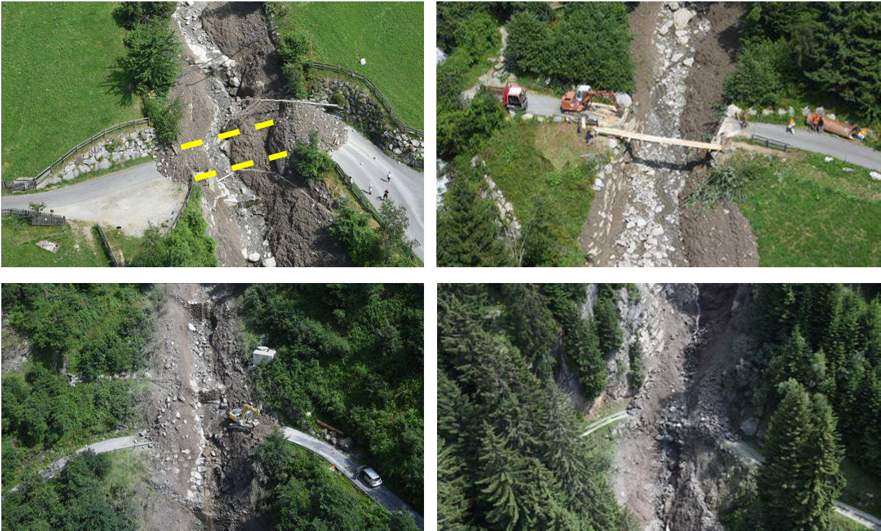
Figura 5: il Rio Höllental ha un elevatissimo potenziale detritico nella parte alta del bacino. Il materiale mobilizzato transita sul ripido versante provocando gravi danni agli attraversamenti
