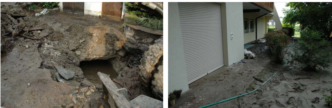
Figura 6: in occasione di eventi temporaleschi il Rio Molino non è in grado di smaltire le portate. I danni, non ingenti ma piuttosto frequenti, potrebbero essere ridotti con semplici accorgimenti strutturali ed organizzativi
