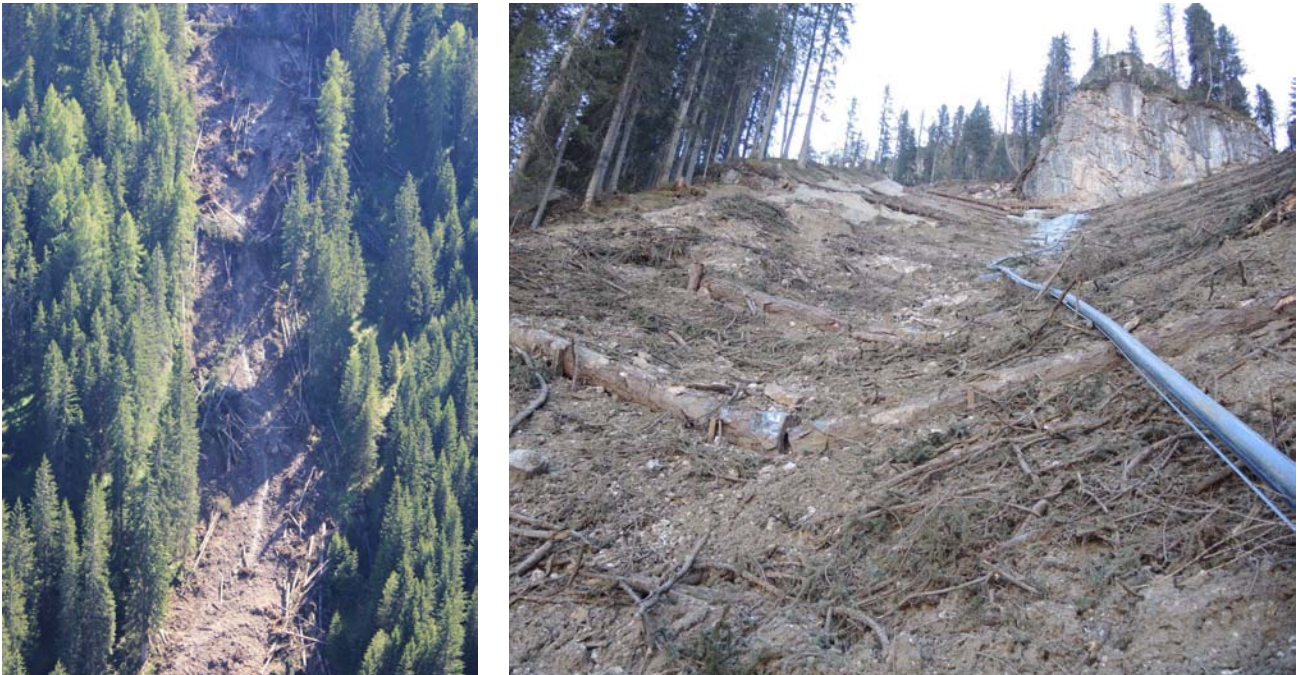
Figura 15: a sinistra la parte centrale della colata detritica di versante ove è chiaramente riconoscibile la densa consistenza del materiale; a destra la zona nel dicembre 2016 dopo la stabilizzazione del versante con opere di ingegneria naturalistica
