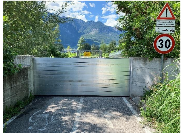
Abb. 4.23: oben links: der bekannte Problempunkt an der Brücke bei Neumarkt. Oben rechts; unten links: der Einsatz der Feuerwehr zur Eindämmung der Qualmwässer (fontanazzi); unten rechts: die mobile Absperrung wurde vorsorglich auf dem Radweg oberhalb von Neumarkt, orografisch links, eingerichtet
