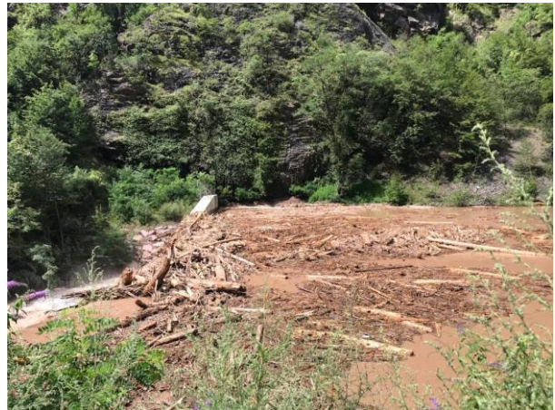
Abb. 4.10: die Filterwirkung der Sperre flussaufwärts von Bozen im Bereich der Sill (links während des Ereignisses vom 18. Juni, rechts am 5. August)
