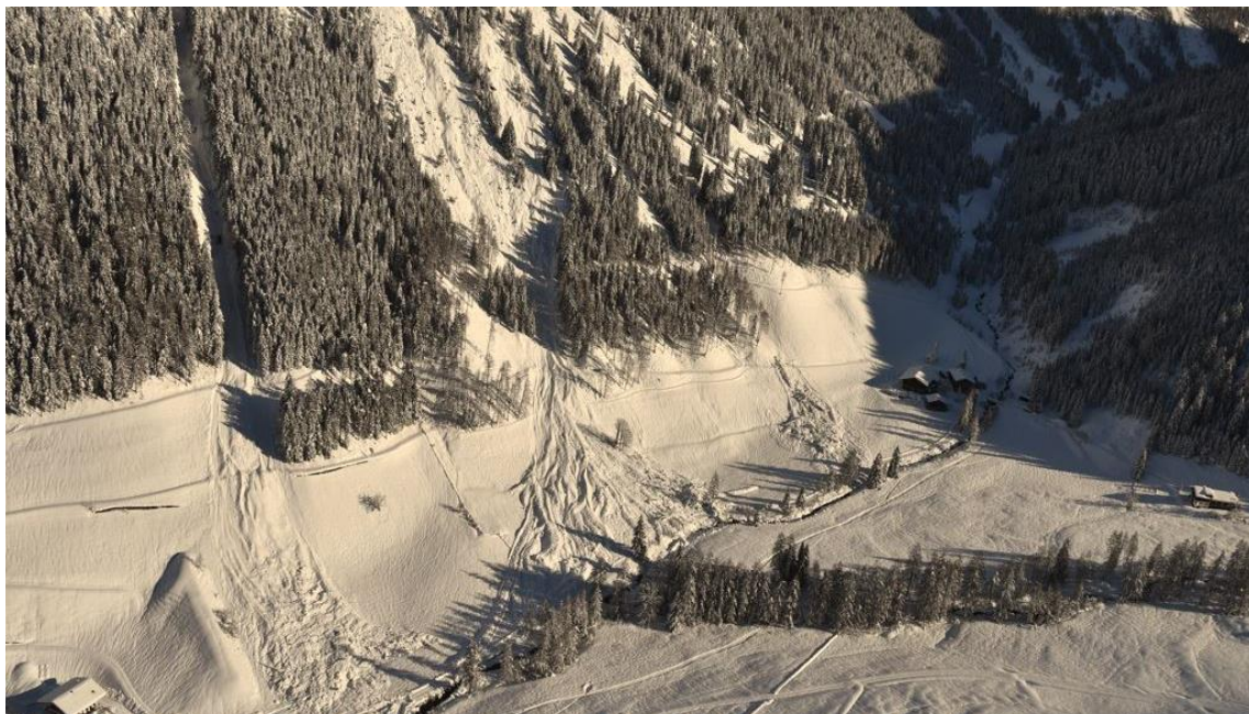
Abb. 6.11: Mehrere Mischlawinen haben die Gemeindestraße zum Wanserhof auf einer Länge von rund 250 m verschüttet. Der Gruberhof im Bild links unten wird durch einen 80 m langen Lawinenleitdamm geschützt.
