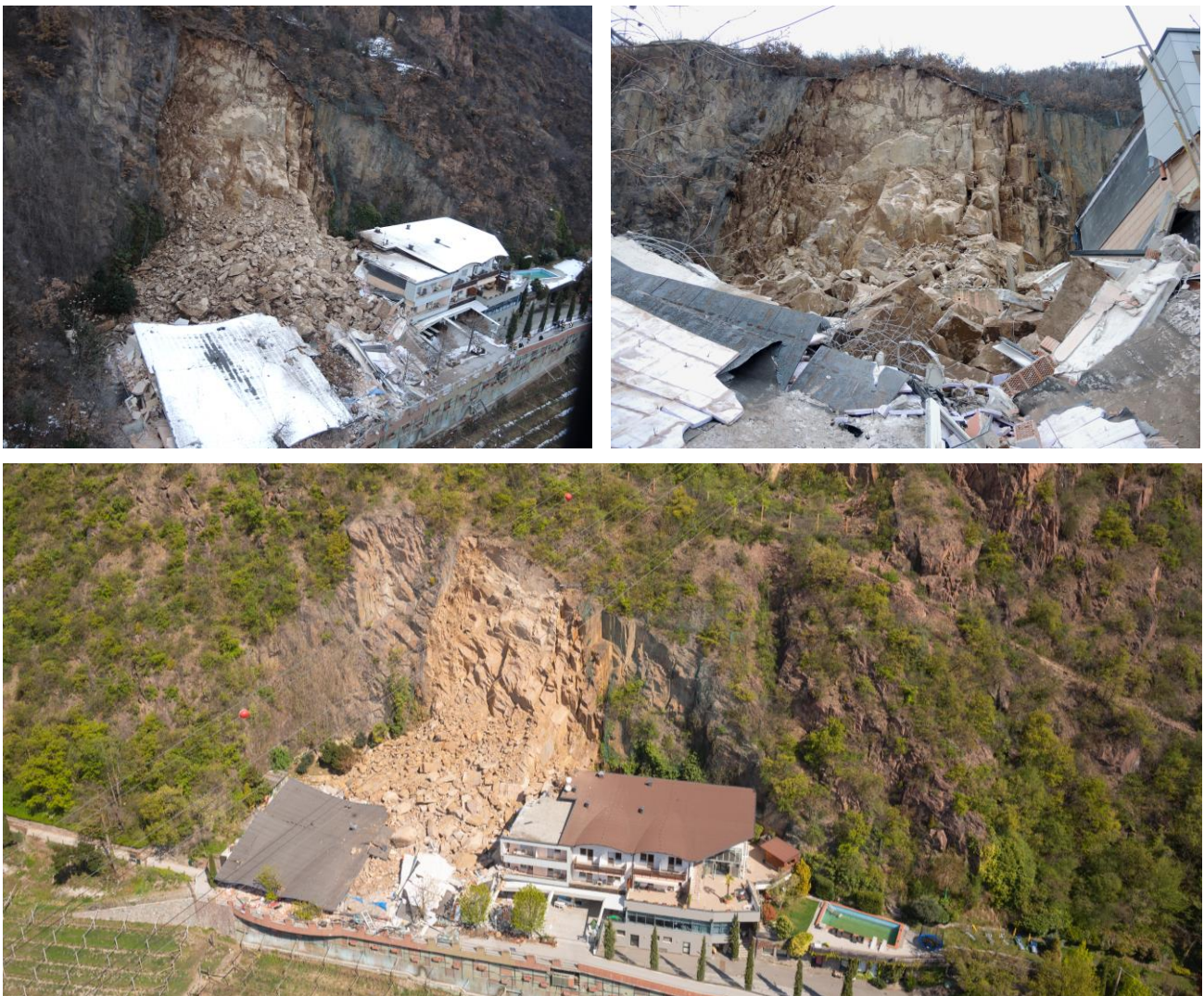
Abb. 5.8: Überblicksaufnahmen des Felssturzes beim Hotel Eberle in St. Magdalena Bozen. Die oberen Fotos wurden direkt am Tag des Ereignisses am 5. Jänner 2021 aufgenommen, das untere hingegen im Frühjahr 2021
