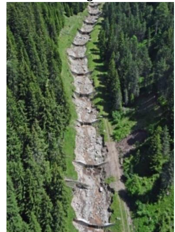
Abb. 4.7: links und Mitte: Heftige Regenfälle, begleitet von Hagel, haben zu neuen Erosionen geführt, welche die Verfügbarkeit von Schutt im Einzugsgebiet erhöhen. Solche Prozesse sind in Analysen zur hydraulischen Gefährdung eher schwierig zu bewerten. Rechts: die Reihe von Konsolidierungssperren, welche vom Amt für Wildbach- und Lawinerverbauung im zentralen Einzugsgebiet errichtet wurden, haben die Erosionsprozesse im Bachbett in Grenzen gehalten.
