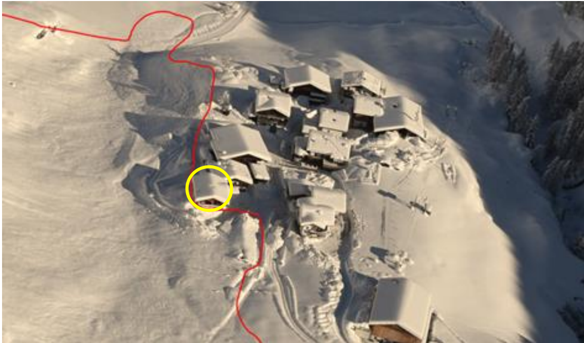
Abb. 6.8: Der Weiler Zeppichl in Pfelders in der Gemeinde Moos in Passeier wurde in der Nacht von 5.-6. Dezember 2020 von mehreren Lawinenabgängen getroffen. Das Gebäude im gelben Kreis wurde dabei beschädigt.
