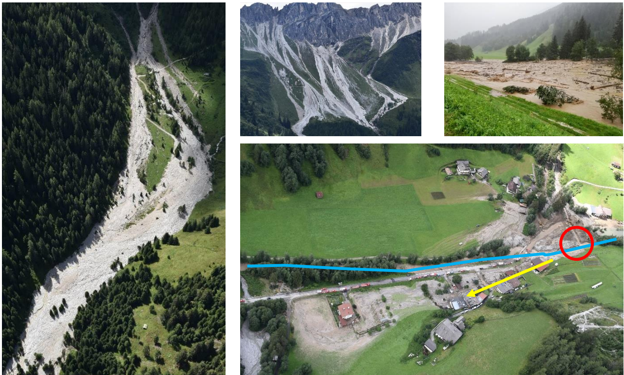
Abb. 4.25: links: das ausgedehnte Ablagerungsgebiet des mobilisierten dolomitischen Schuttmateriale (ca. 25.000 - 35.000 m 3 ); oben Mitte: die Schuttablagerungen im oberen Teil des Einzugsgebietes; oben rechts: die Ablagerung an der Einmündung, die den Pflerer Bach verlegte. Unten rechts: das vom Pflerer Bach (gelbe Linie) überflutete Gebiet auf der orographisch linken Seite, kurz nach der Verklausung durch den Toffringbach (roter Punkt)
