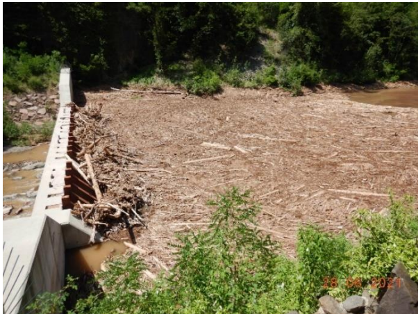
Abb. 4.10: die Filterwirkung der Sperre flussaufwärts von Bozen im Bereich der Sill (links während des Ereignisses vom 18. Juni, rechts am 5. August)
