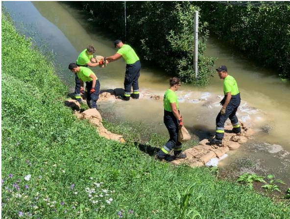
Abb. 4.23: oben links: der bekannte Problempunkt an der Brücke bei Neumarkt. Oben rechts; unten links: der Einsatz der Feuerwehr zur Eindämmung der Qualmwässer (fontanazzi); unten rechts: die mobile Absperrung wurde vorsorglich auf dem Radweg oberhalb von Neumarkt, orografisch links, eingerichtet
