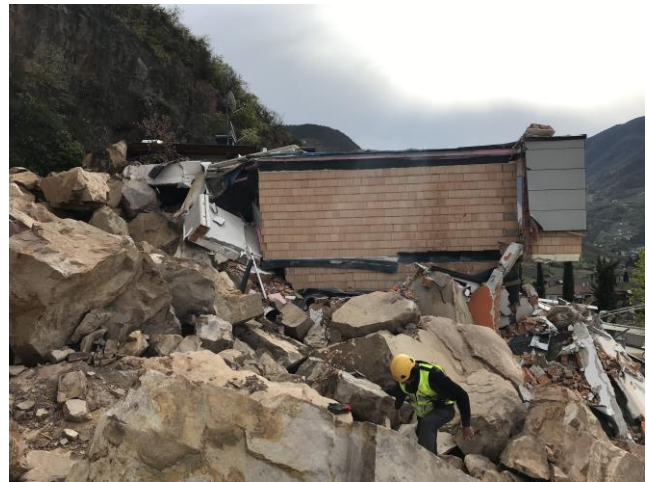
Abb. 5.9: Der bergseitige Bereich des Hotels: einzelne Blöcke erreichen Volumina von über 20 m 3 . Die massive Struktur hat jedoch verhindert, dass das Felssturzmateriale weiter talwärts gelangen konnte.
