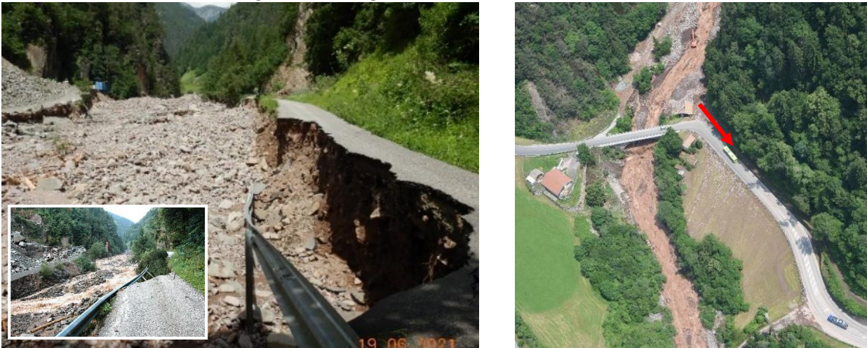
Abb. 4.8: links: das Hochwasser hat die Zufahrtsstraße zu den Bauernhöfen fast vollständig erodiert (im Kasten ein ähnliches Phänomen aus dem Jahr 2009); rechts: an der Brücke über die LS überschwemmte der Tanzbach auf der orographisch linken Seite die Fahrbahn und die darunter liegenden Wiesen.
