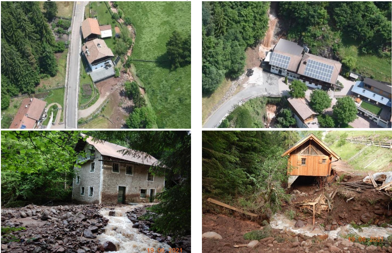
Abb. 4.9: Situationen am Wangenerbach, in denen es zu Konflikten zwischen Siedlungen und Naturphänomenen kommt. In einigen Fällen wurde sicherlich schon vor Genehmigung der Verordnung zu den Gefahrenzonenplänen gebaut.
