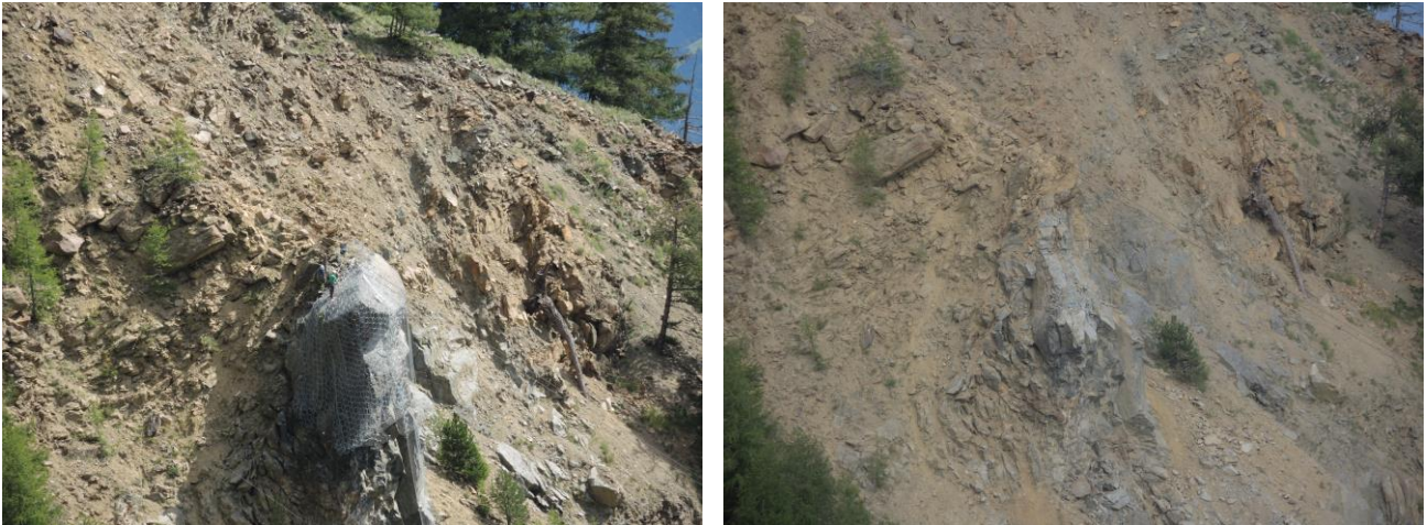
Abb. 5.11: Im Vorfeld der Sprengung wurde der Fels in ein Netz eingehüllt, um zu verhindern, dass die Gesteinsbrocken bei der Sprengung unkontrolliert umherfliegen. Rechts im Bild der Kastenknott nach der erfolgten Sprengung
