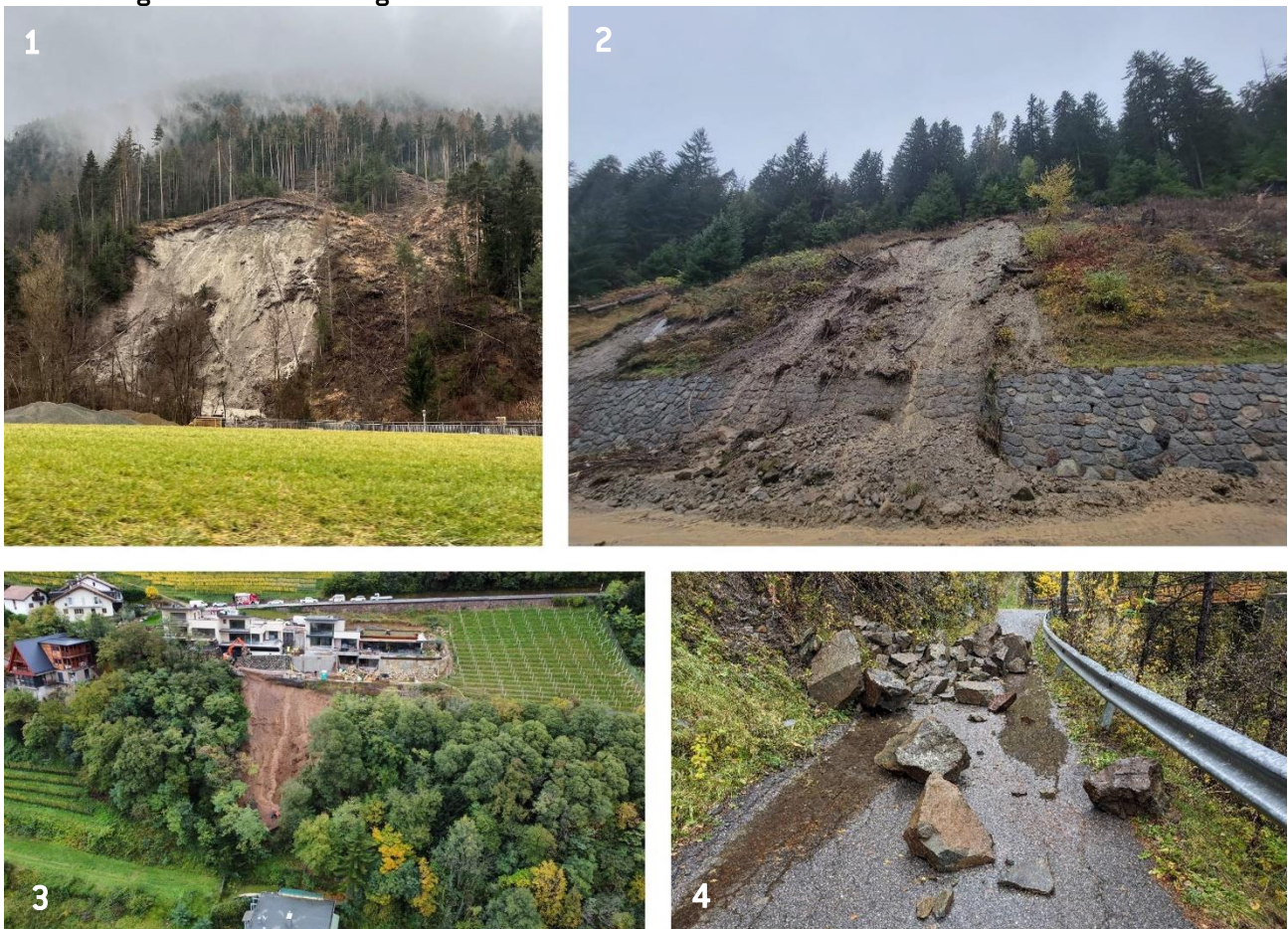
Abb. 5.16: Diverse Ereignisse, die die Starkniederschläge von Ende Oktober bis Anfang November 2023 mit sich gebracht haben. (1) Rutschung bei Mittermühl, Gemeinde Villnöss; (2) Hangmure bergseitig der Straße nach Sulden; (3) Hangmure talseitig des Neubaus Mazzoner Straße Nr. 8-14, Gemeinde Neumarkt; (4) Steinschlag auf die Zufahrtsstraße Innernördersberg, Gemeinde Schlanders.
