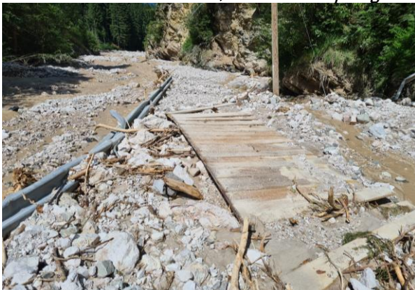
Abb. 4.10: Die Brücken über den Furkelbach wurden beschädigt oder vollständig von Geröllmaterial zerstört
