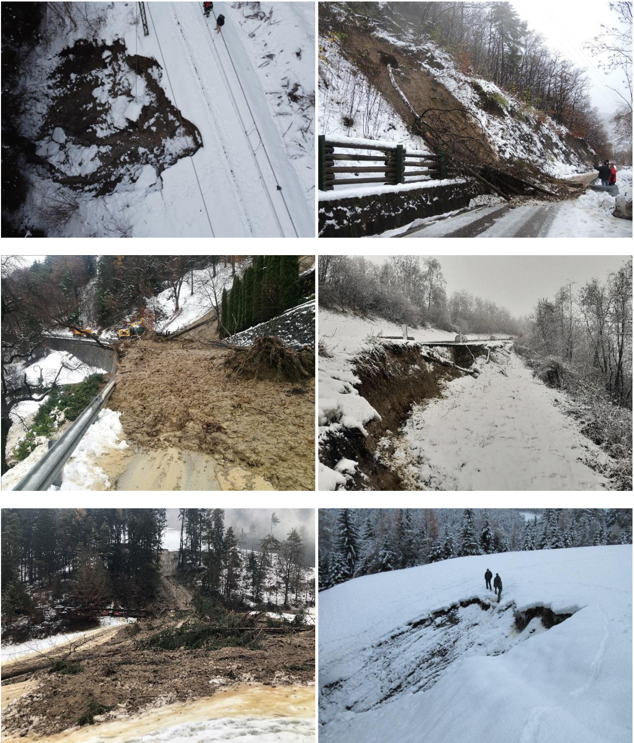
Abb. 37: Die Bilder verdeutlichen die Auswirkungen, welche das Tiefdruckgebiet vom 5. bis 9. Dezember 2020 mit sich gebracht hat. Von oben links nach unten rechts: Rutschung bei der Pustertaler Bahnlinie in der Gemeinde Bruneck; Hangmure entlang der Sirmianerstraße in der Gemeinde Nals; Hangmure bei der Völser Straße in der Gemeinde Völs; Rutschung talseitig der Pustertaler Straße bei Percha; Hangmure bei der Pustertaler Staatsstraße bei Kiens; Rutschung und Hangmure oberhalb der Ortschaft Mauls in der Gemeinde Freienfeld
