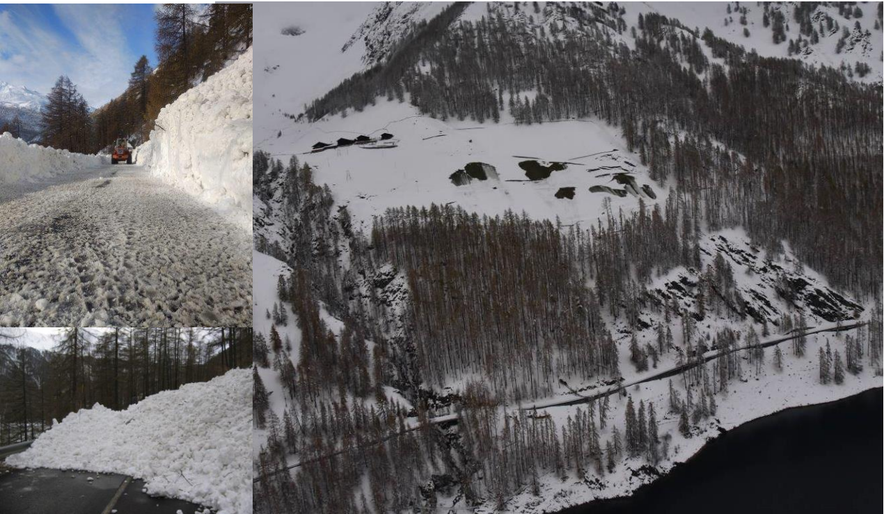
Abb. 47: Gleitschneerutsche- und Lawinen aus den Finailwiesen verschütteten die Landesstrasse Nr:3
