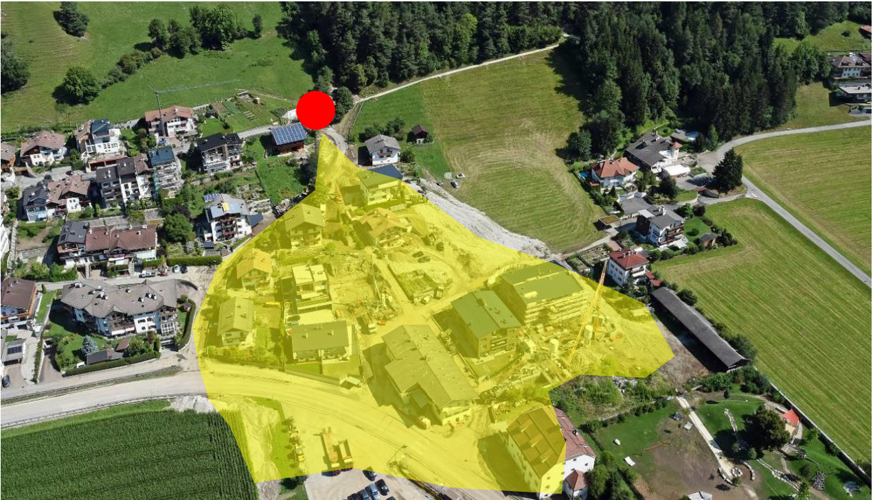
Abb. 17: Hubschrauberaufnahme der Fraktion Obervintl: Der rote Punkt markiert den verstopften Abfluss, der gelbe Bereich das von der Mure betroffene Gebiet. Der gewöhnliche Niedrigwasserabfluss des Horner Grabens wird über einen unterirdischen Kanal, der durch das Dorf führt, abgeleitet
