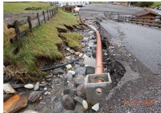
Abb. 27: Schäden an den Infrastrukturen am Ennewasserbach, Martell (Ereignis 2020025 vom 30. Juli 2020) und am Plantalbach (Pfledererbach), Moos i.P. (Ereignis 2020157 vom 2. Oktober 2020)
