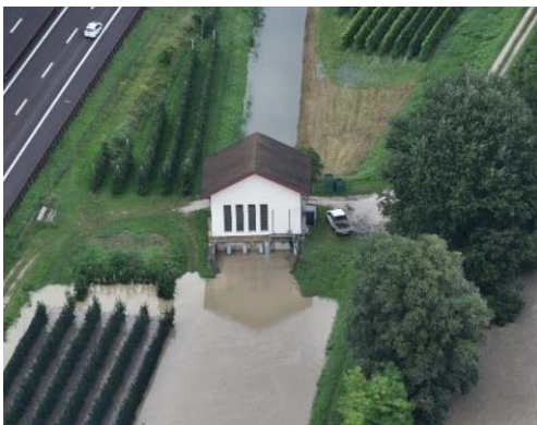
Abb 6: oben links das Hochwasserereignis an der Brücke bei Neumarkt, einem der hydraulisch kritischen Punkte der Etsch im Unterland; oben rechts, einer der Wasseraustritte im Bereich des Dammes erforderte den Einsatz der Freiwilligen Feuerwehr
