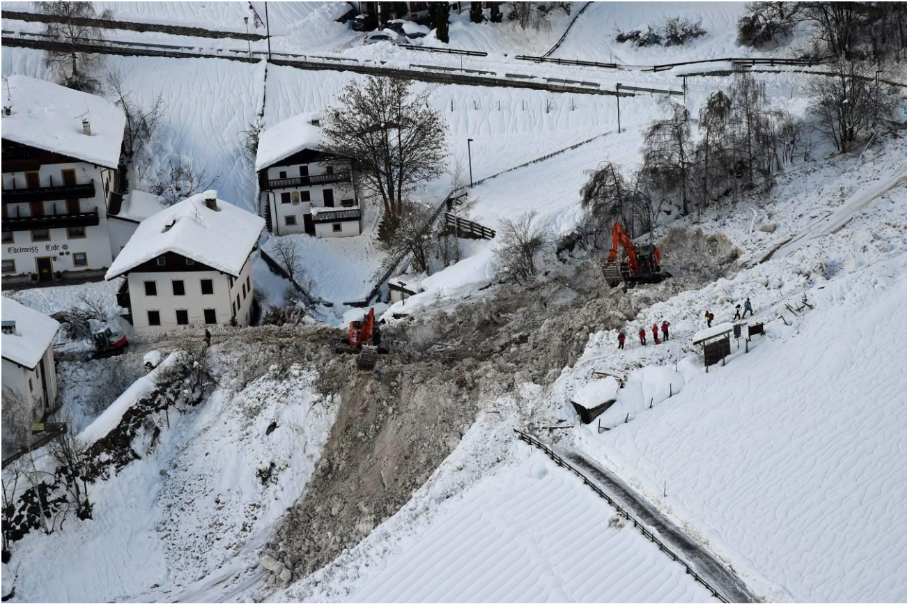
Abb. 48: Am Sonntagvormittag den 17. November 2019 donnert die Eberhöfertal Lawine zu Tal. Ein Lawinenarm zwingt sich durch zwei Lawinenleitdämme am Dorfrand von Martell und fließt rund 35m der Hauptstraße entlang
