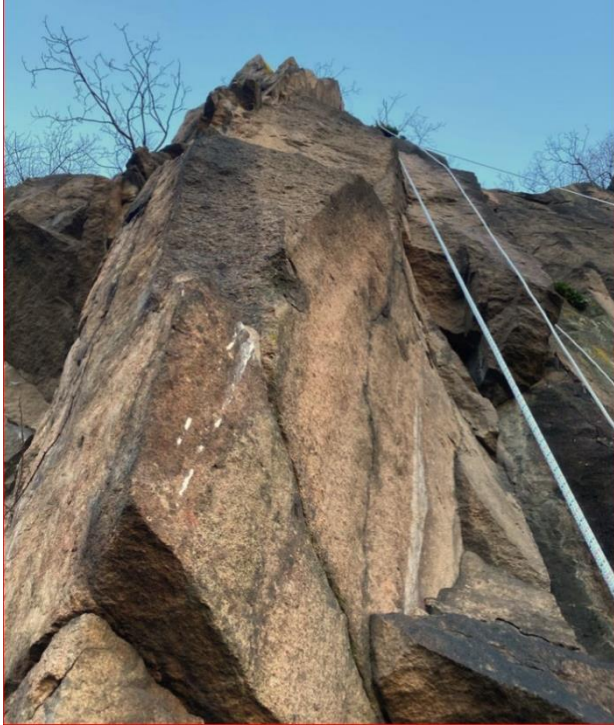
Abb. 35: Links und rechts oben im Bild die instabile Felsmasse bergseitig der Staatsstraße im Bereich des Virgls, mit einem geschätzten Volumen von etwa 300 m 3 . Aufgrund von Frost-Tauwechsel und vor allem wegen der starken Regenfälle vom November 2019 hatten sich die Stabilitätsverhältnisse des Felskeils stark verschlechtert, sodass dieser dringend gesprengt werden musste
