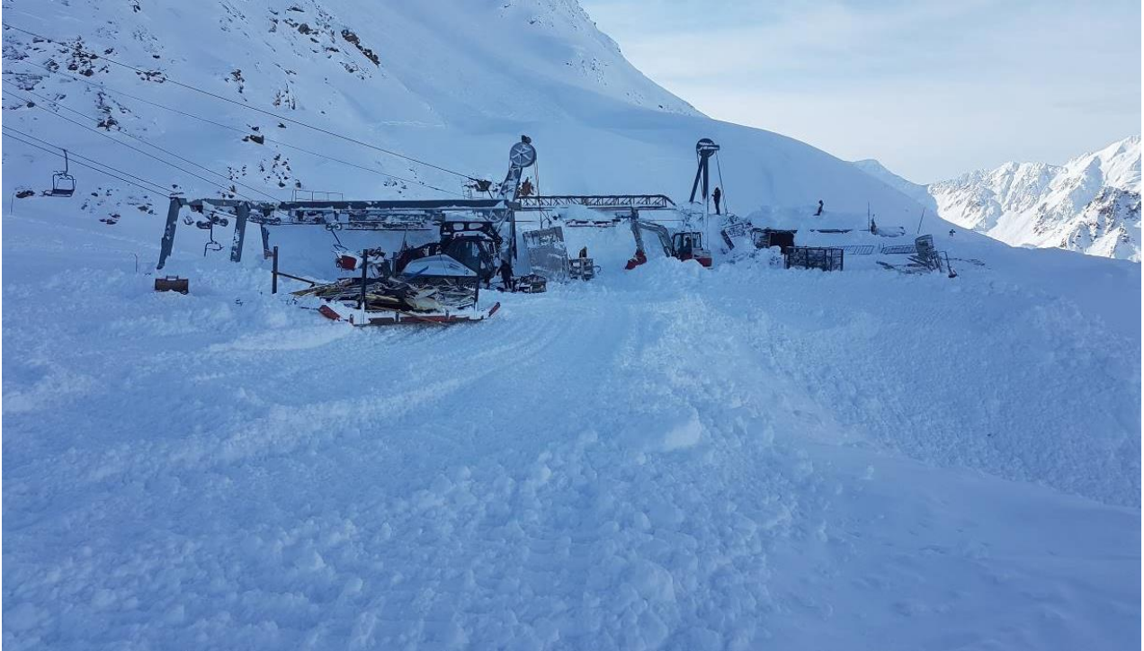
Abb. 42: Aus den felsigen Nordhängen der grauen Wand bricht in den Morgenstunden vom 15. November ein 150m breites Schneebrett an und verschüttet die Talstationen der Gletscherseesessellifte 1 + 2 über 4m hoch
