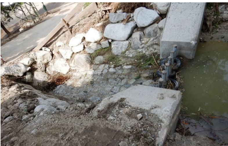
Abb. 18: Links: der Schacht nach den Aufräumarbeiten, er ist nur ausreichend für durchschnittliche Regenfälle; rechts die vorderste Front des Murganges (Murkopf) im Dorf
