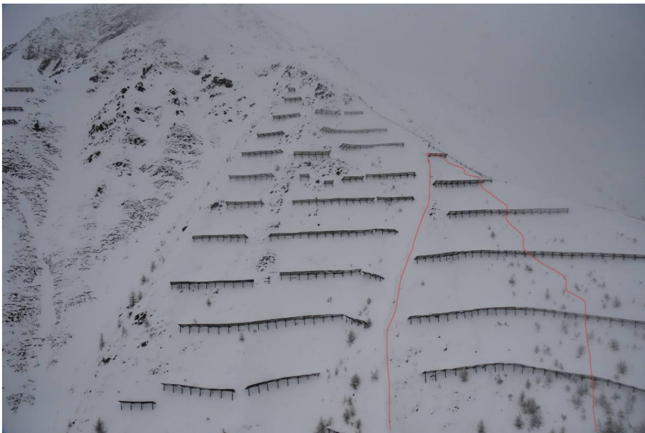
Abb. 44: Teilweise ist der Neuschnee durch die Stahlschneebrücken der Lawinenanbruchverbauung gerutscht
