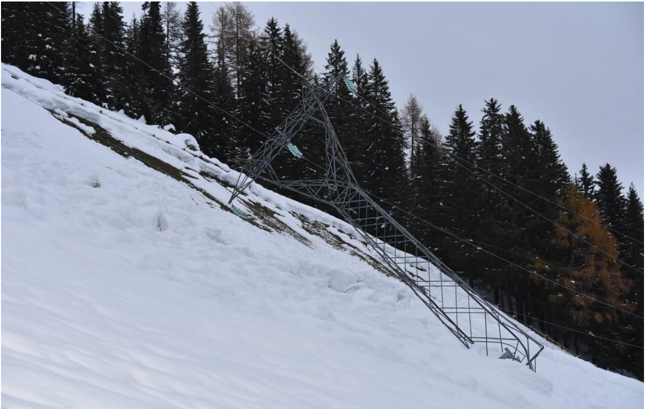
Abb. 62: Von einem Gleitschneerutsch neben der Hofstelle Öberstein in der Gemeinde Ulten umgelegter Strommasten
