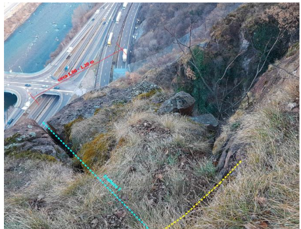
Abb. 35: Links und rechts oben im Bild die instabile Felsmasse bergseitig der Staatsstraße im Bereich des Virgls, mit einem geschätzten Volumen von etwa 300 m 3 . Aufgrund von Frost-Tauwechsel und vor allem wegen der starken Regenfälle vom November 2019 hatten sich die Stabilitätsverhältnisse des Felskeils stark verschlechtert, sodass dieser dringend gesprengt werden musste
