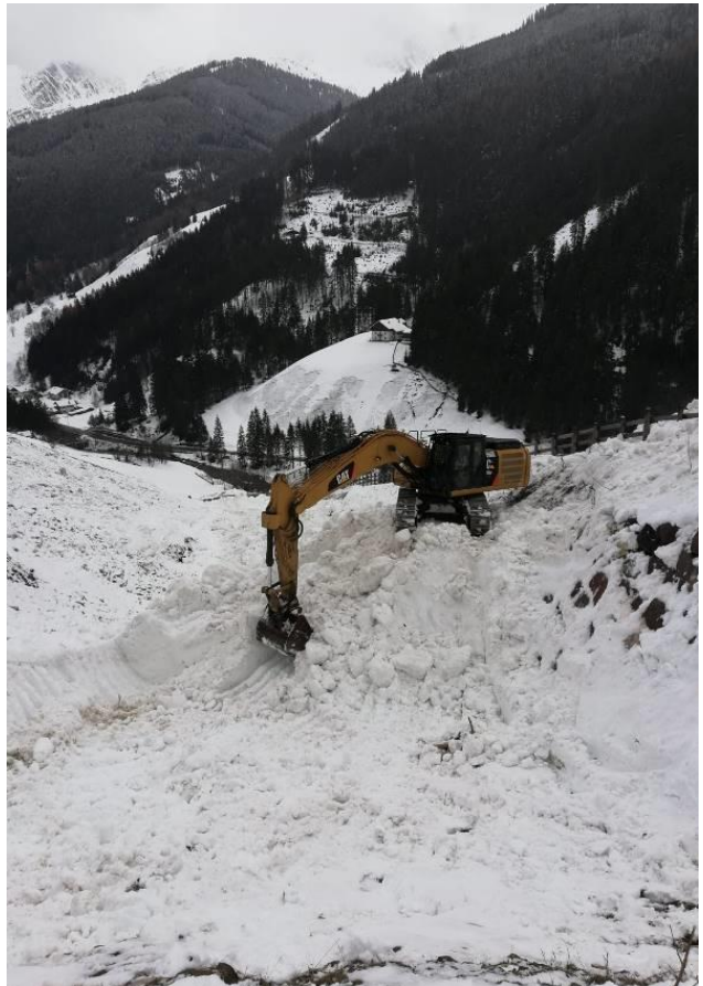
Abb. 58: Im linken Bild der Teisslgraben Lawinenleitdamm im Pflerschertal und rechts im Bild das Ausräumen des Lawinenschnees aus dem Leitdamm
