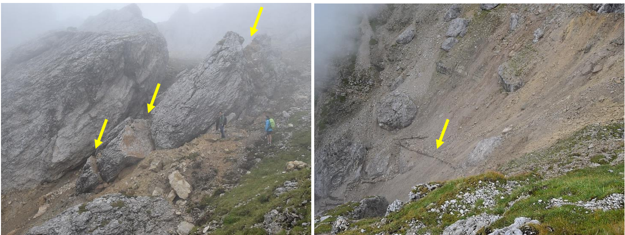
Abb. 34: Links oben im Bild ein Teil der Blockmasse aus Schlern-Dolomit, die aufgrund der Bewegungen bereits abgebrochen ist. Man beachte die Dimensionen der Blockmasse! Rechts im Bild der durch die starken Niederschläge vermutete und stark beschädigte Steig Nr. 6
