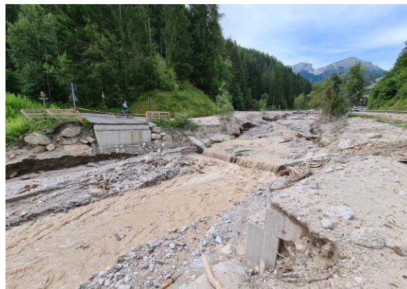
Figura 4.10: i ponti sul Rio Furcia sono stati danneggiati o completamente distrutti dal materiale detritico
