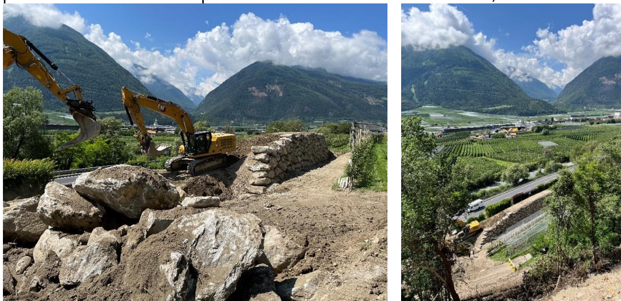
Figura 5.11: Lavori in somma urgenza per la realizzazione del tomo-vallo paramassi presso la statale della Val Venosta
