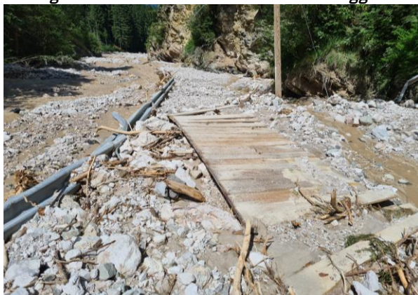
Figura 4.10: i ponti sul Rio Furcia sono stati danneggiati o completamente distrutti dal materiale detritico
