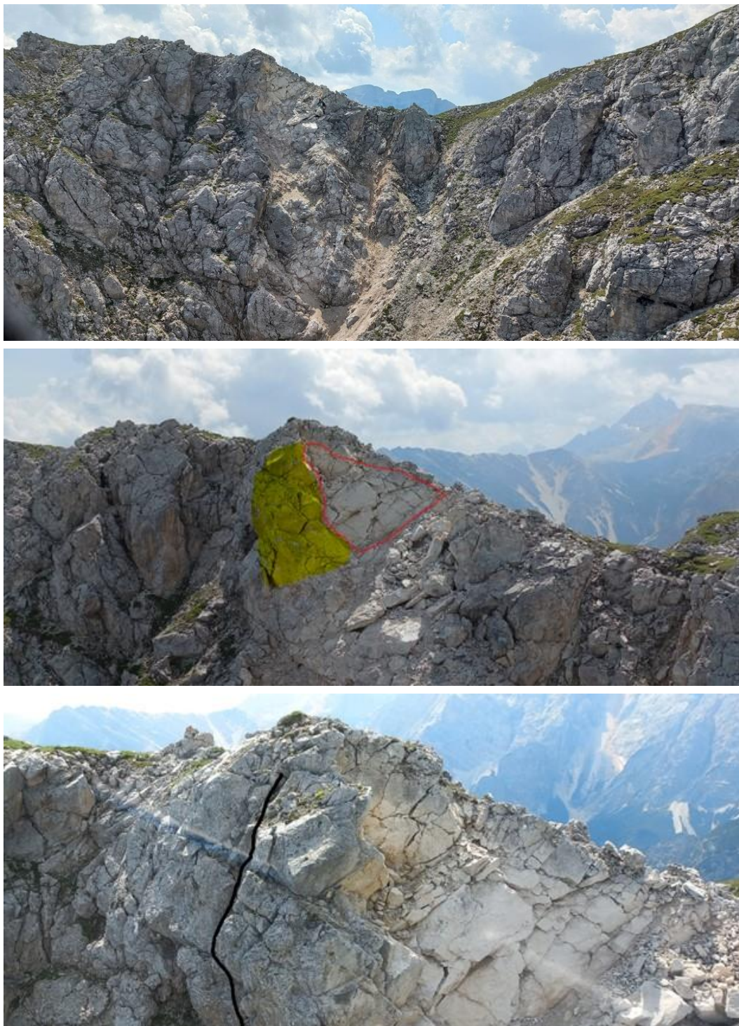
Figura 5.12: Crollo in roccia sul Terzo Spiz nelle Dolomiti di Braies. Foto d'insieme dell'area di crollo sulla cresta della cima; foto dettagliata della nicchia di distacco (rosso) e dell'area instabile (giallo); fessura di trazione aperta vicino alla nicchia di crollo recente
