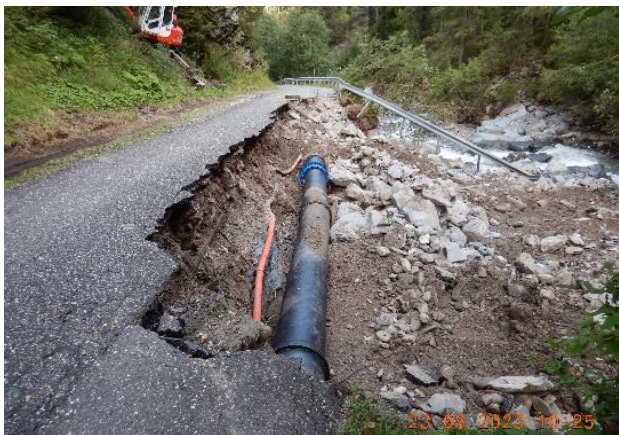
Figura 4.16: il Rio di Lasanca, alimentato dalle colate detritiche di vari affluenti, ha provocato gravi danni alle strade
