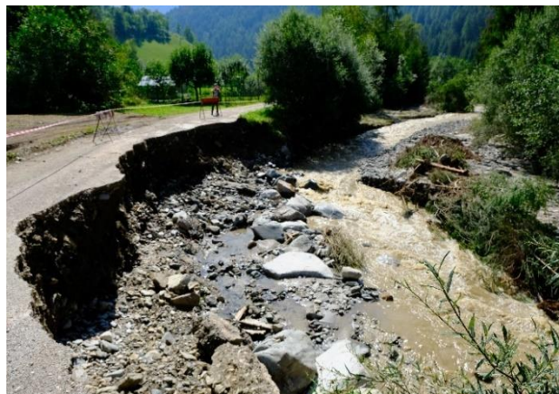
Figura 4.16: il Rio di Lasanca, alimentato dalle colate detritiche di vari affluenti, ha provocato gravi danni alle strade
