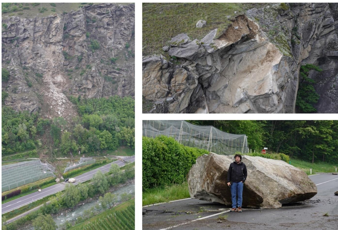
Figura 5.8: Impatto del blocco sulla Strada Statale 38 dal km 172+250 al km 172+380. Fotografia aerea dell'area di distacco, del percorso di caduta e dell'area di deposito, scattata la mattina del 22 maggio; fotografia aerea della nicchia di distacco a quota 770 m s.l.m.; foto del blocco di crollo più grande, con un volume di circa 30 m 3 (1,9 x 4 x 4 m), arrestatosi sulla carreggiata della Strada Statale 38
