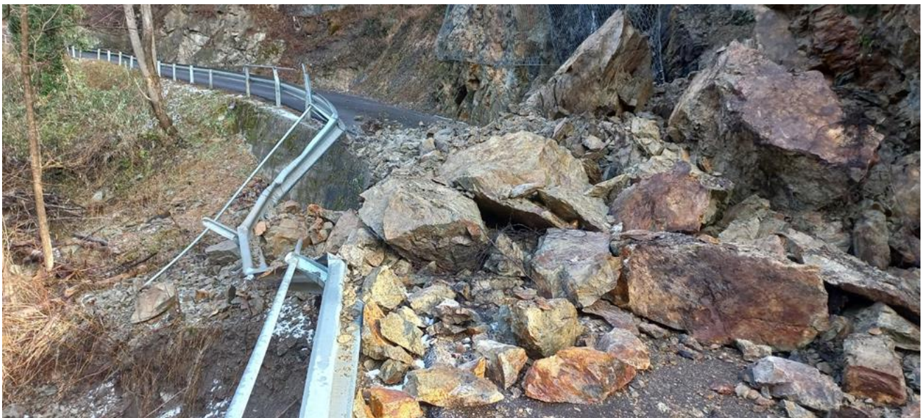
Figura 5.4: Le foto mostrano diversi tipi di frane. In alto a sinistra, una colata di versante lungo il pendio boscato sul lato a monte della Strada Provinciale 24 verso Castelrotto. In alto a dx, un masso crollato che ha raggiunto il muro dell'asilo vicino a Vandoies di Sotto. La foto al centro mostra una caduta massi che ha colpito la Strada Comunale Val Tina vicino a Chiusa e ha distrutto la rete adiacente. L'immagine in basso a sx mostra uno dei numerosi scivolamenti superficiali che si sono verificati a causa di tre sistemi di bassa pressione consecutivi all'inizio di novembre 2023 e che hanno portato forti precipitazioni.
