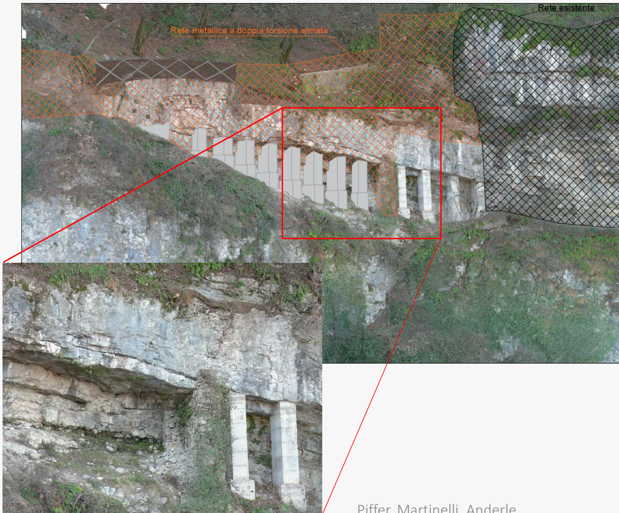
Sezione tipo di consolidamento mediante barbacani in CA
