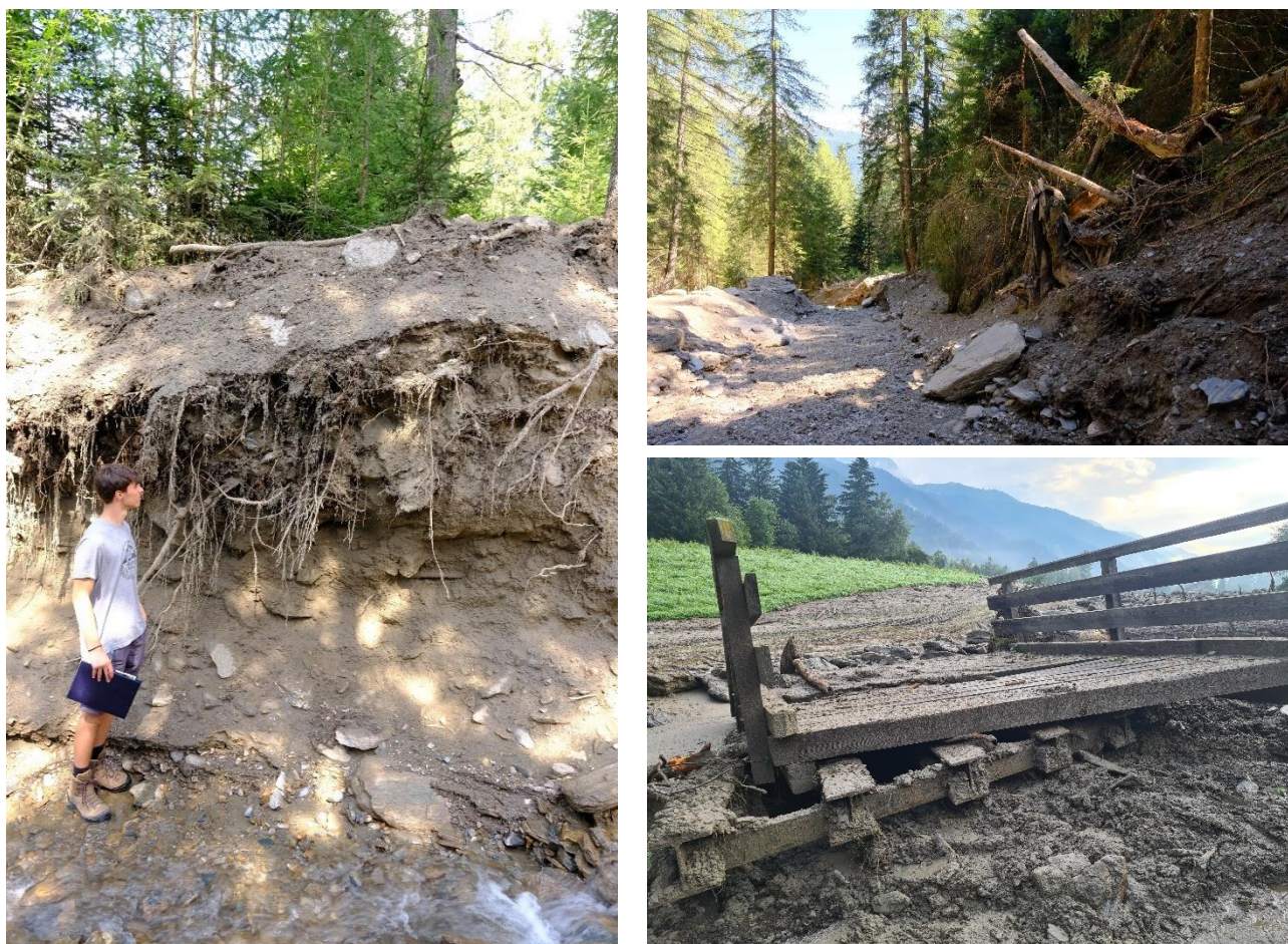
Figura 4.18: fenomeni erosivi e danni ad attraversamenti sul Rio di Febbesa [B.605.100, evento 2024062], adiacente al Rio di Transacqua.
