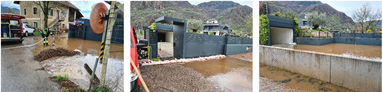
Figura 4.7: i depositi vegetali che si accumulano nei fossati di fondovalle possono causare l'occlusione di attraversamenti e la conseguente esondazione. Anche se caratterizzati da livelli e velocità limitati, questi eventi possono arrecare danni anche ingenti agli edifici ed in particolare ai piani sotterranei, se non opportunamente protetti.
