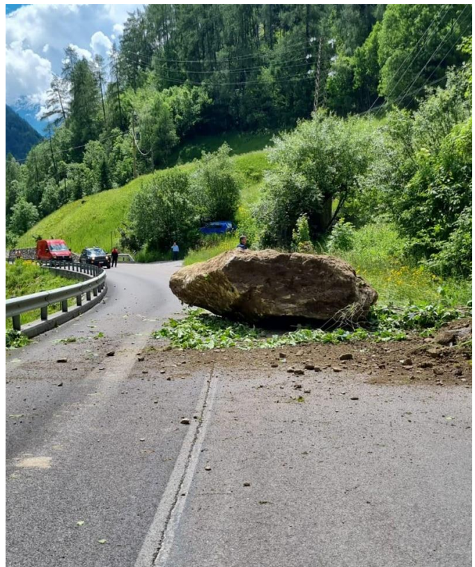
Figura. 5.8: A causa della caduta massi del 5 giugno, la strada che porta in Val Senales è rimasta chiusa ancora a lungo. (ASP/Servizio strade)
