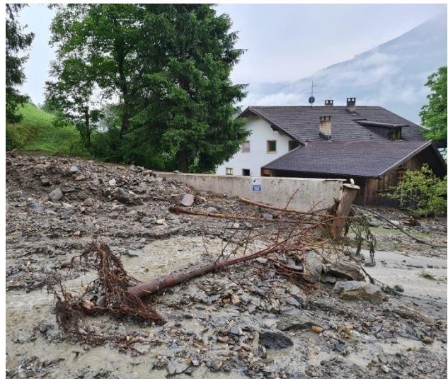
Figura 4.13: le precipitazioni intense hanno innescato diffuse frane superficiali sui prati ripidi le scarpate della strada verso Partinges. I detriti sono stati trasportati nel fossato Kirch, dove sono stati parzialmente intercettati dai muri di difesa recentemente realizzati dall'Ufficio Bacini montani Nord.
