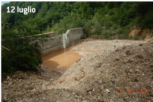
Figura 4.9: il bacino di trattenuta, ultimato nel 2019 dai tecnici e dagli operai dell'Ufficio Sistemazione Bacini montani SUD, ha intercettato la quasi totalità di sedimenti mobilizzati dai tre eventi accaduti nel corso del 2024. L'opera riduce drasticamente la pericolosità del Rio di Montagna, che a valle dell'opera scorre proprio adiacente a numerosi edifici storici del paese.
