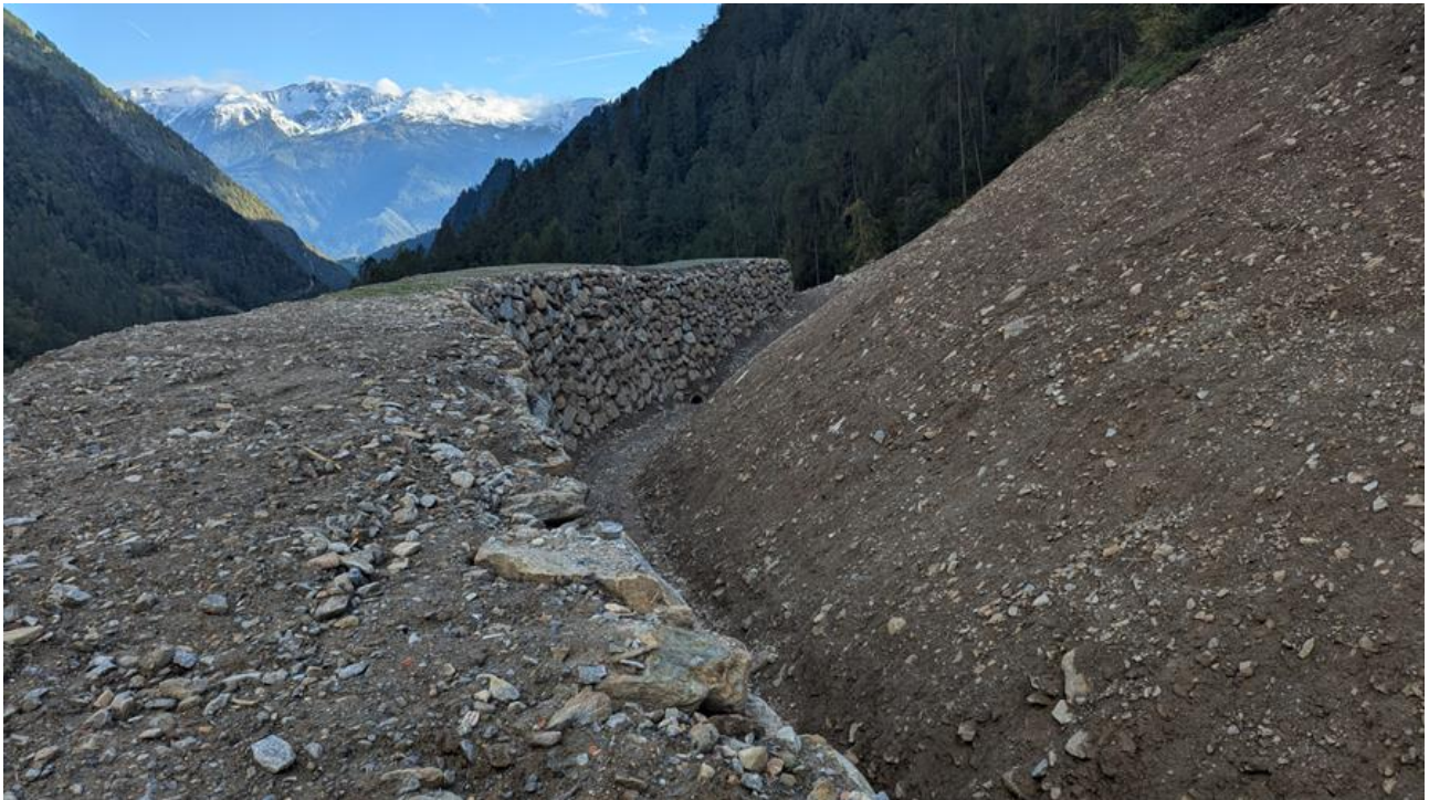
Figura 5.14: Tomo-vallo realizzato in muratura ciclopica con una lunghezza totale di 180 m e un'altezza di 10 m.
