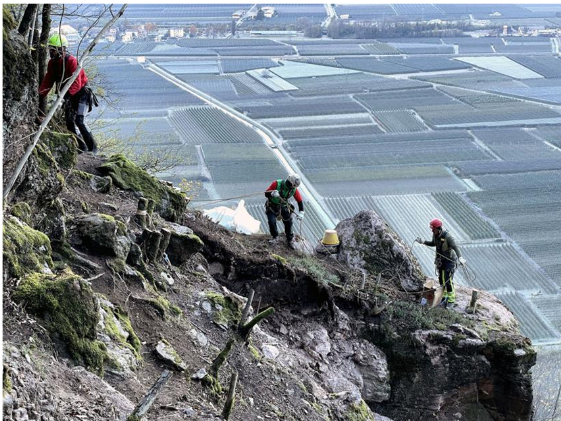
Figura 5.24: Preparazione del brillamento: L'esplosivo viene depositato con perizia dallo specialista di brillamento e dal suo team, mentre gli alberi vengono abbattuti prima del brillamento per facilitare l'accesso allo sperone roccioso.
