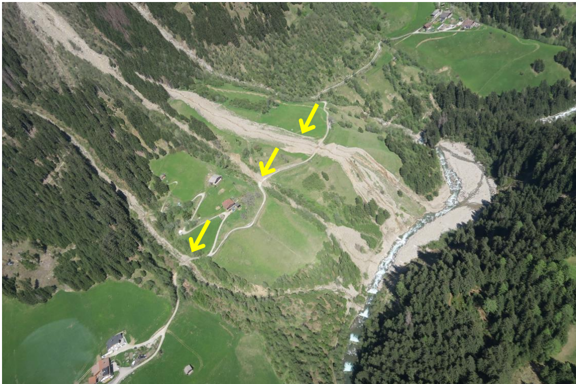
Figura 5.19: Area di accumulo della frana con la frazione di Geraine in sinistra orografica del Rio Mareta. Le grandi quantità di detriti nei canaloni morfologici e l'elevata disponibilità di acqua dovuta alle precipitazioni hanno portato a colate detritiche secondarie (freccie gialle).
