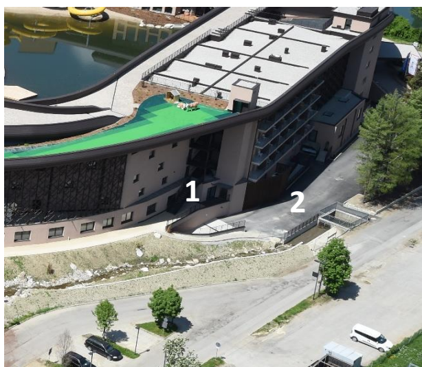
Figura 4.8: A sx si può vedere come l'accesso ai garage (1) è stato progettato in prossimità dell'imbocco del sottopasso che permette al rio di attraversare la strada (2) per poi raggiungere il fiume Rienza. Durante l'evento detriti hanno immediatamente occluso il sottopasso causando l'esondazione del rio; il fango è quindi entrato nel garage attraverso la rampa di accesso, che non presentava misure di riduzione della vulnerabilità
