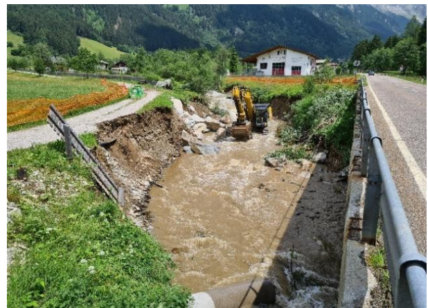
Figura 4.11: L'alluvione torrentizia sul Rio di Anterselva ha provocato fenomeni localizzati di esondazione e diffuse erosioni laterali.
