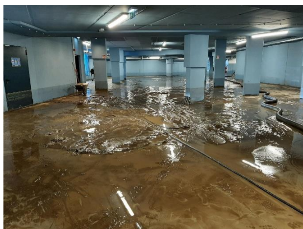
Figura 4.9: a sinistra l'alluvionamento del garage sotterraneo dell'Hotel Lido, che ha richiesto l'intervento dei vigili del fuoco volontari. Anche un modesto fenomeno di ruscellamento, se trova un punto di entrata, può causare ingenti danni negli spazi interrati in particolare a veicoli e impianti tecnici. A destra i detriti depositati nelle aree a giardino
