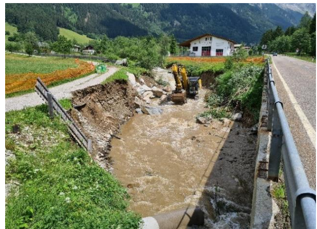
Abb 4.11: Die Übersarung des Antholzer Baches führte zu lokalen Überschwemmungserscheinungen und großflächiger Seitenerosion.
