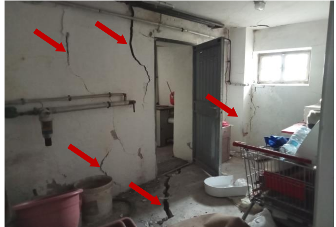
Abb 5.4: Die Fotos zeigen verschiedene Arten von Massenbewegungen. Links oben ein Blockschlag auf das Firmengelände der Handwerkerzone Dick, Gemeinde Sarntal. Der Sturzblock hat dabei den bestehenden Steinschlagschutzdamm übersprungen und ist bis in die Handwerkerzone vorgedrungen. Rechts im Bild oben sieht man die Auswirkungen eines langsamen Hangkriechens beim Café Schlehdorf an der Tappeiner Promenade. Die roten Pfeile zeigen die Zugrisse im Gebäude. Unten ein Felssturz im Bereich des Latemars in der Gemeinde Welschnofen, wo ein ganzer Felsturm mit etwa 2.000 m 3 Felsmaterial abgebrochen ist.
