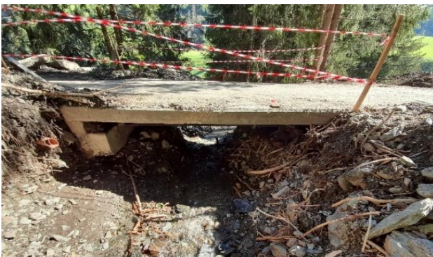
Abb. 4.19: Links ist die Brücke über die Forststraße von Cianacei zu sehen, deren Verklauung dazu führte, dass der Fluss nach rechts und links überlief. Rechts die Schuttmassen, die das Hotelgebäude erreichten.
