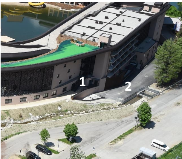
Abb 4.8: Auf dem linken Bild ist die Lage der Garagenzufahrt (1) ersichtlich. Diese Zufahrt wurde in der Nähe der Unterführung angelegt, wodurch das Wasser des hochwasserführenden Baches über die Straße abfließt (2) und dann wieder in die Rienz mündet. Im Zuge des Ereignisses führte die massenhafte Ansammlung an Geröll zu einer Verstopfung der Unterführung. Dies führte wiederum zum Überlaufen des Baches; der angeschwemmte Schlamm gelangte daher ungehindert über die Zufahrtsrampe in die Garage.
