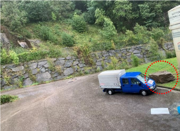
Abb 5.4: Die Fotos zeigen verschiedene Arten von Massenbewegungen. Links oben ein Blockschlag auf das Firmengelände der Handwerkerzone Dick, Gemeinde Sarntal. Der Sturzblock hat dabei den bestehenden Steinschlagschutzdamm übersprungen und ist bis in die Handwerkerzone vorgedrungen. Rechts im Bild oben sieht man die Auswirkungen eines langsamen Hangkriechens beim Café Schlehdorf an der Tappeiner Promenade. Die roten Pfeile zeigen die Zugrisse im Gebäude. Unten ein Felssturz im Bereich des Latemars in der Gemeinde Welschnofen, wo ein ganzer Felsturm mit etwa 2.000 m 3 Felsmaterial abgebrochen ist.
