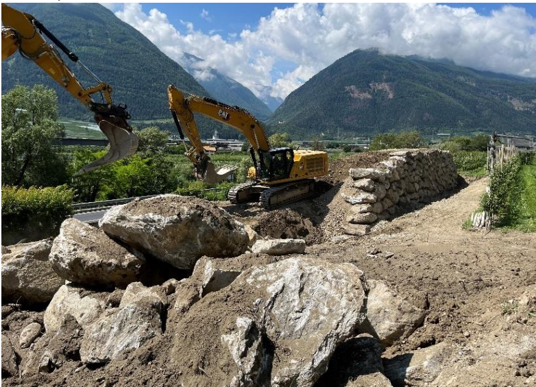
Abb. 5.11: Arbeiten höchster Dringlichkeit zur Realisierung des Steinschlagschutzdammes im Bereich der Vinschgauer Staatsstraße
