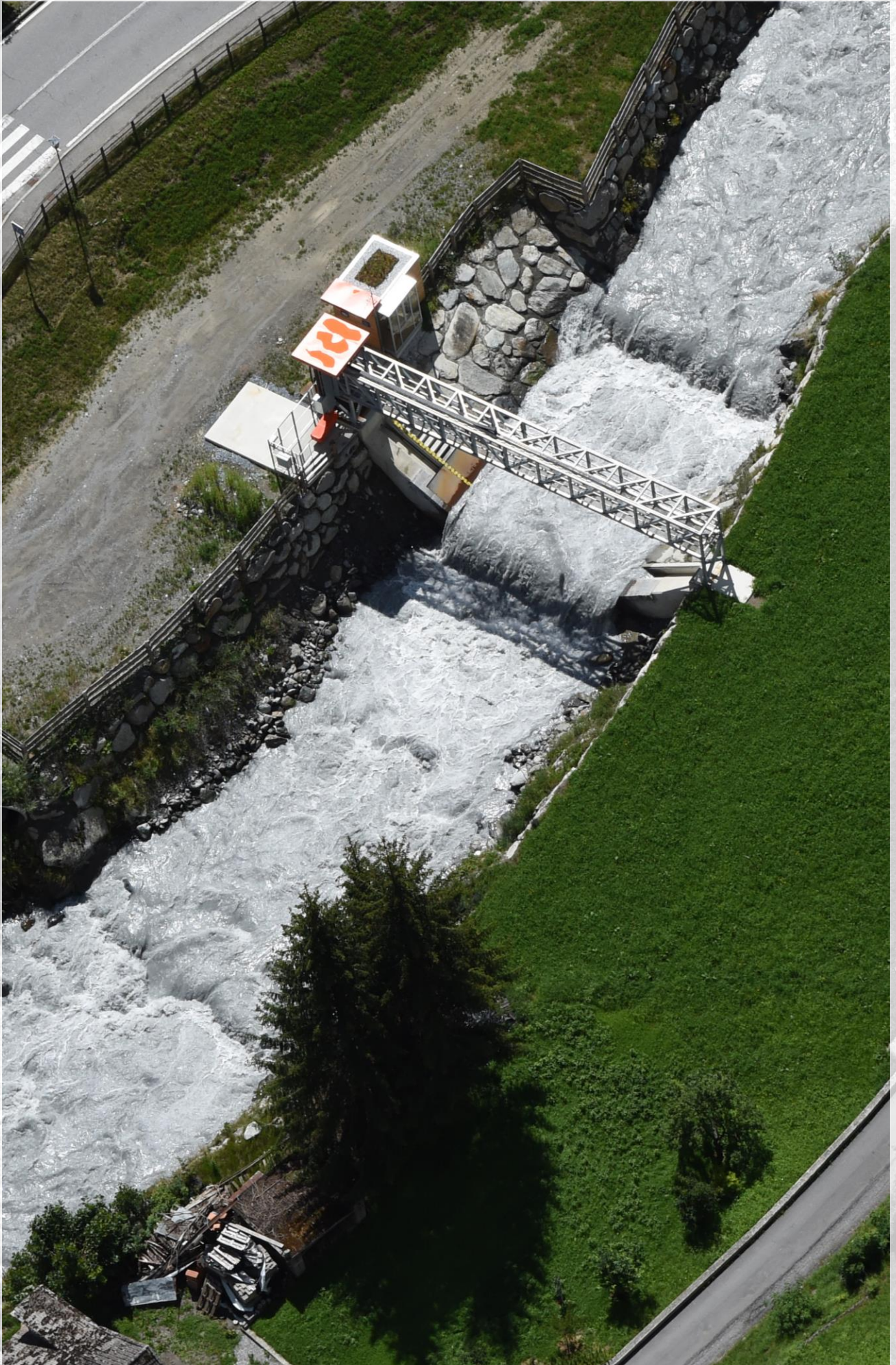
Pegelmessstelle Stilfser Brücke – Stilfs
