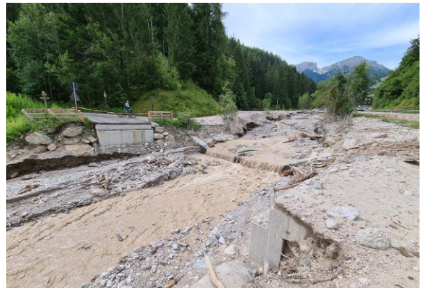
Abb. 4.10: Die Brücken über den Furkelbach wurden beschädigt oder vollständig von Geröllmaterial zerstört
