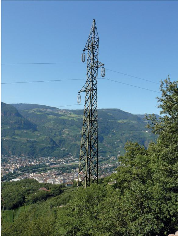
Abb. 2: Beispiel einer einfachen Leitung bestehend aus Strommast, Leitern und Erdungskabel.
