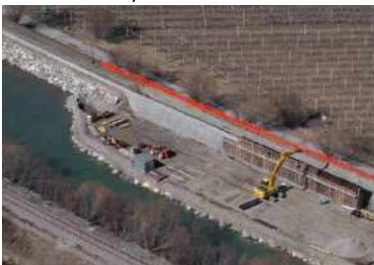
Fig. 71 Intervento di rinforzo dell'argine dell'Adige tramite l'allestimento di un diaframma
