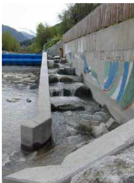
Fig. 113 Passaggio per pesci realizzato sul Torrente Aurino presso l'opera di derivazione di un impianto idroelettrico
