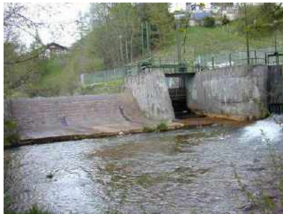
Fig. 30 Opera di derivazione per impianto idroelettrico
