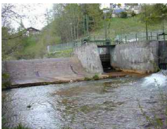
Fig. 111 Opera di derivazione per impianto idroelettrico
