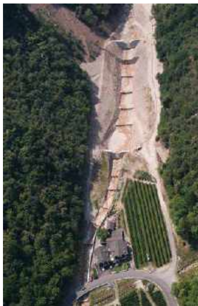
Fig. 76 Interventi realizzati sul Rio Grissiano a protezione dell'abitato di Nalles
