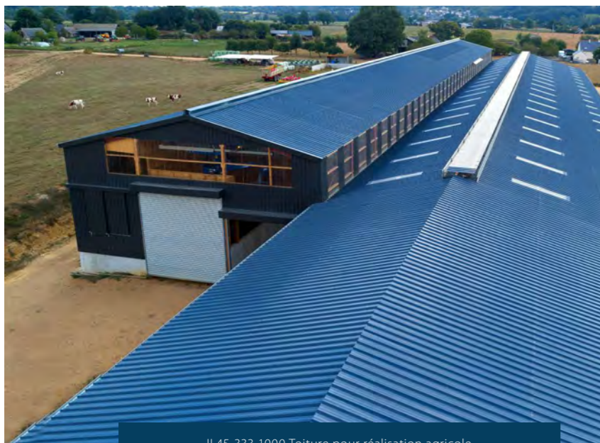
JI 45-333-1000 Toiture pour réalisation agricole.
