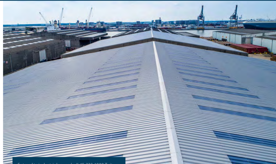
Entrepôts industriels avec le JI 45-333-1000 Toiture.
