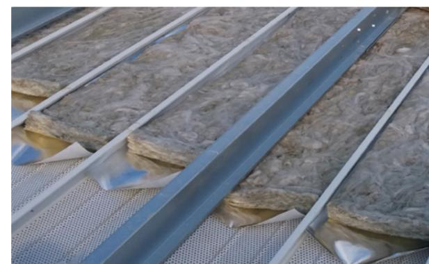
Dans le cas de plateau perforé, la pose préalable d'un voile protecteur (type voile de verre, etc.) est requise lorsque l'isolant ne présente pas de surfaçage en sous-face.
