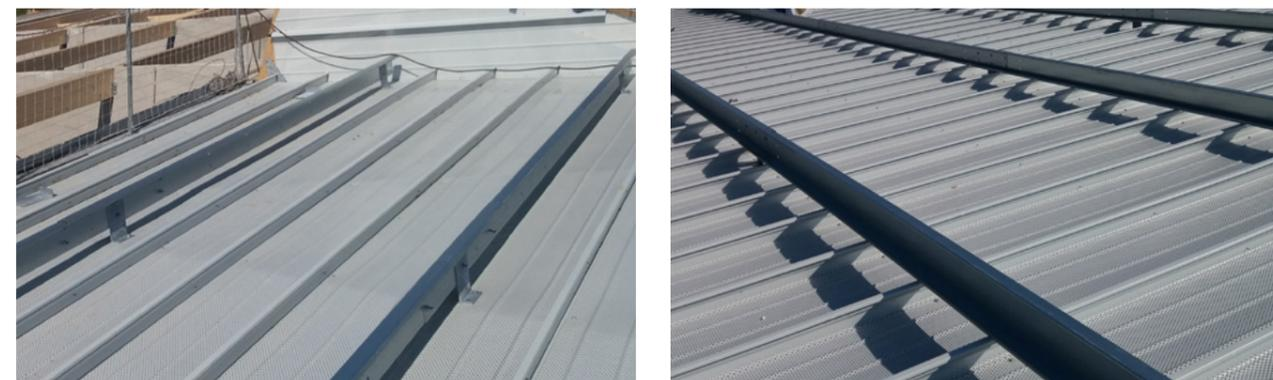
Les fausses pannes peuvent répondre aux prescriptions du § 5.3.1 du DTU 40.35 et se fixent par boulonnage sur les échantignoles préalablement posées. Ces échantignoles peuvent être également fixées par boulonnage, ou vissage dédié au-travers du plateau ou directement à la charpente; le plateau ayant été préalablement découpé. Nous consulter pour plus d'informations sur cette étape.
