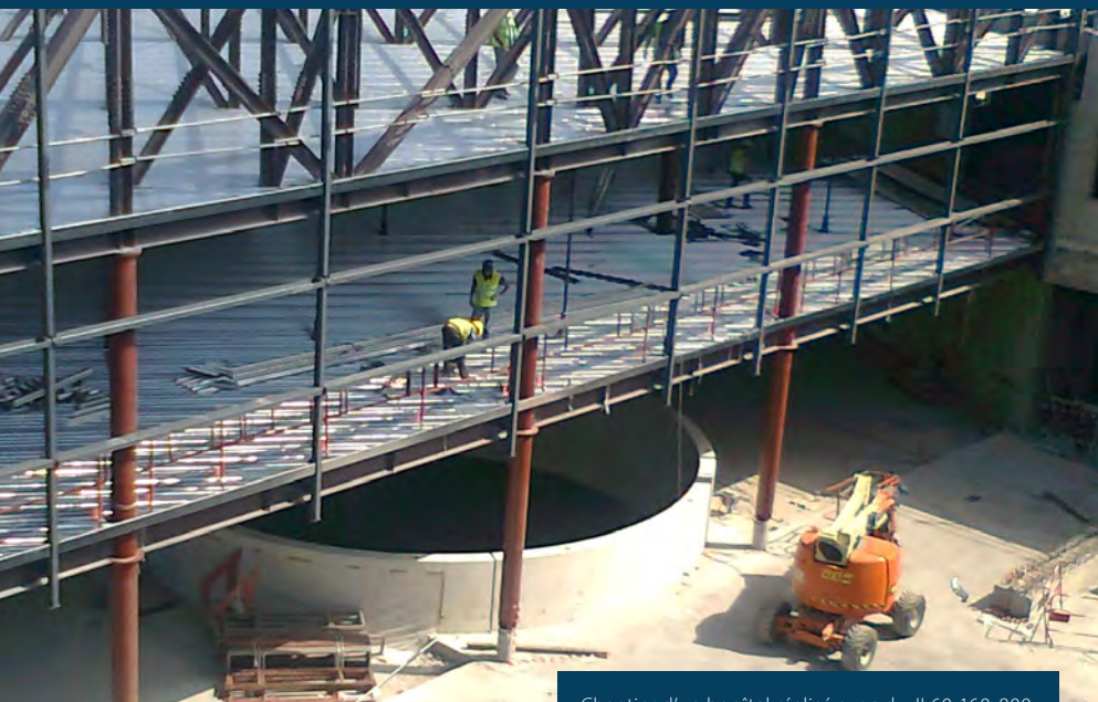
Chantier d'un hôpital réalisé avec du JI 60-160-800.
