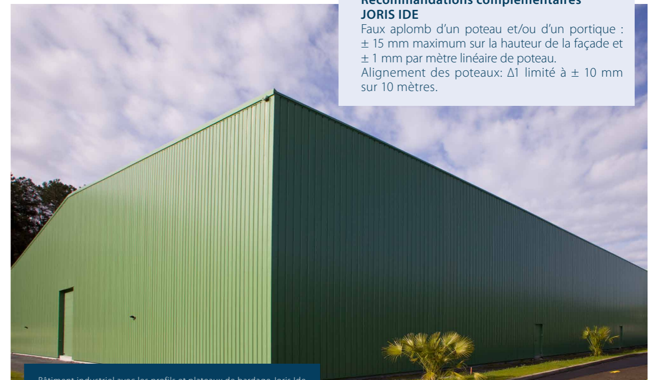
Bâtiment industriel avec les profils et plateaux de bardage Joris Ide
