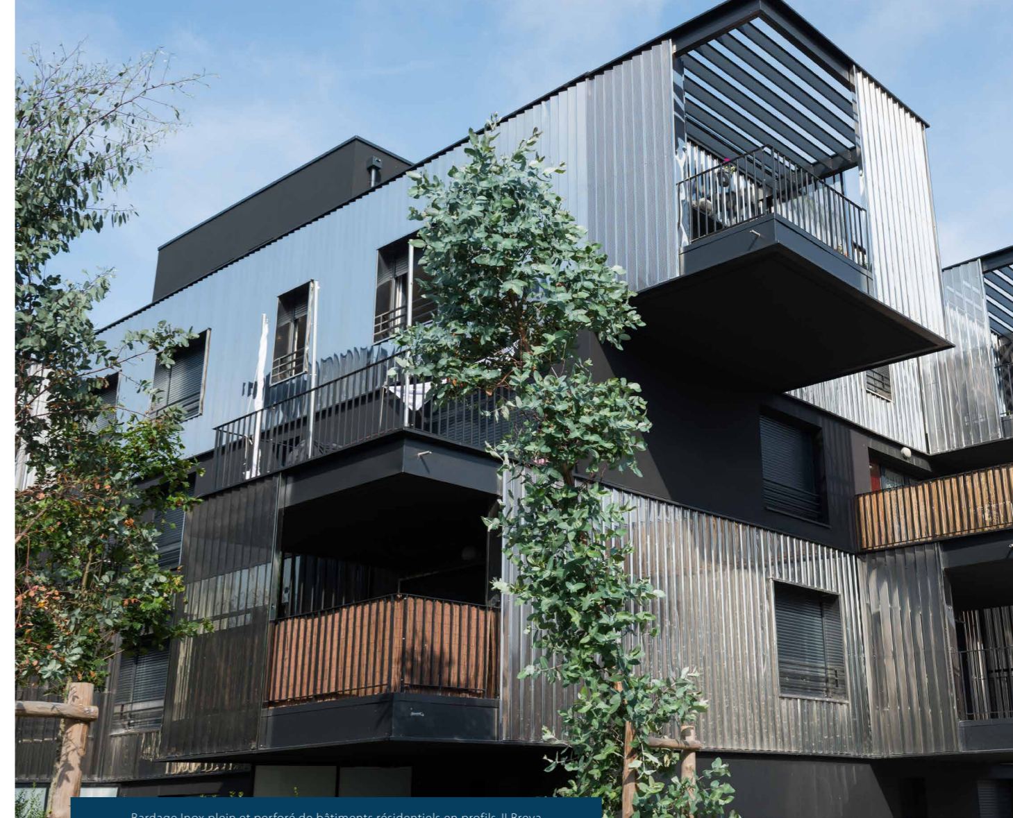
Bardage Inox plein et perforé de bâtiments résidentiels en profils JI Breva
