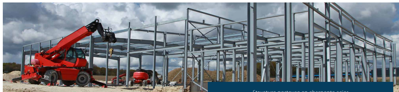
Structure porteuse en charpente acier
