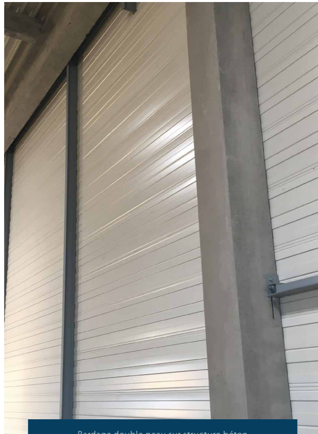
Bardage double peau sur structure béton
