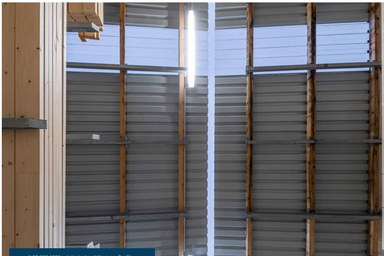
JI 37-207-1035 mit Lichtdurchlässigen Profilen
